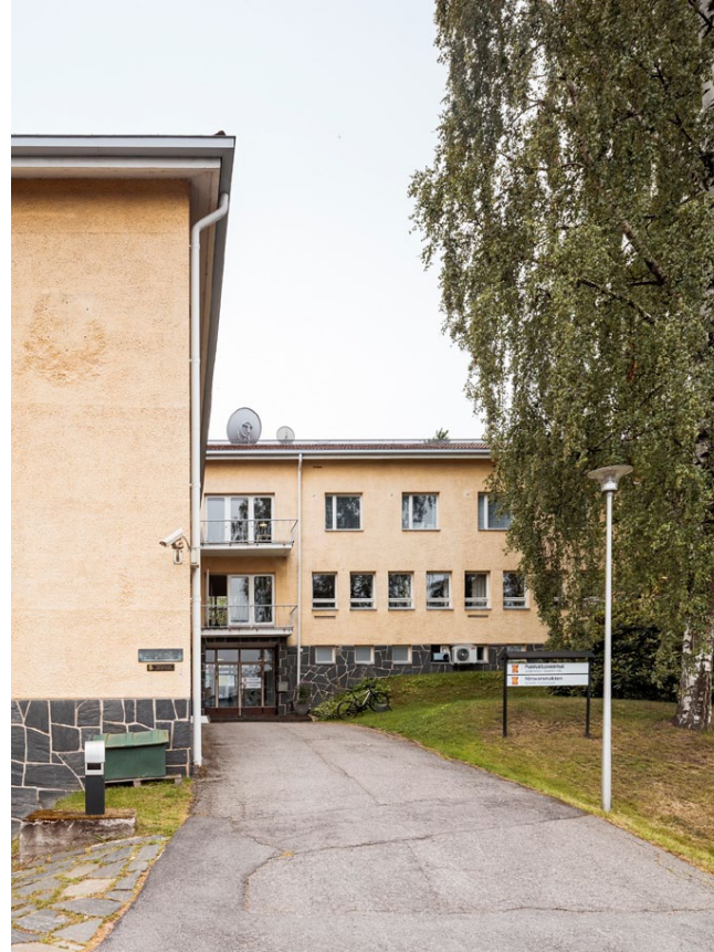
Suojeltavan päärakennuksen (RAK A) sisäänkäynti
