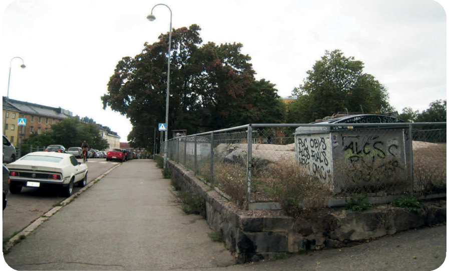
Kuva 51. Pengerpuiston koirapuisto on rakennettu puiston luonnonkivisten muurien rajaamalle tasanteelle. Muurin päällä on verkkoaita. Puiston kalusteita, varusteita ja rakenteita on töhritty.
