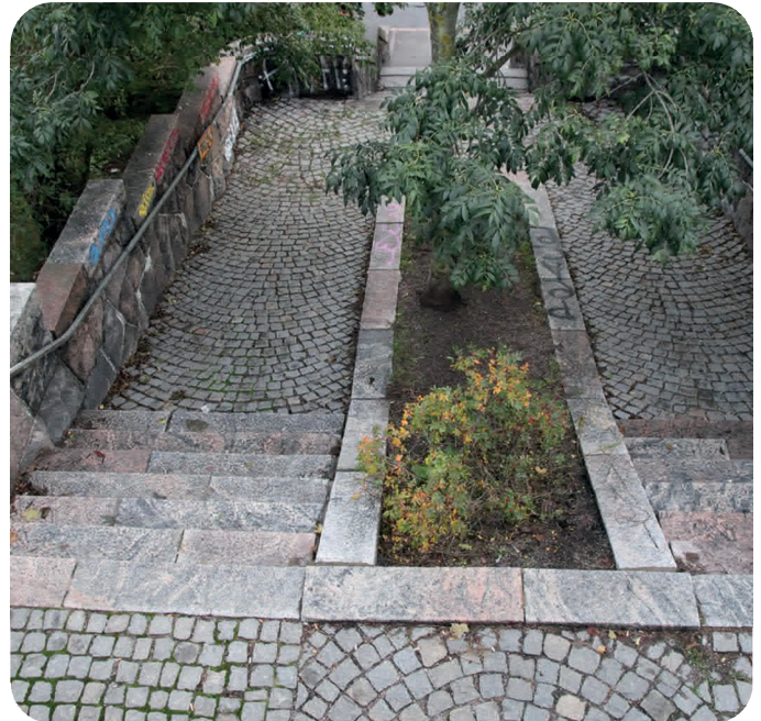
Kuva 49. Pengerpuiston pienempi osuus on muurein rajattu istutettu osa, jonka jakaa kahtia luonnonkiviportaait. Muureja ja kalusteita on töhritty, ja istutukset ovat aukkoiset.
