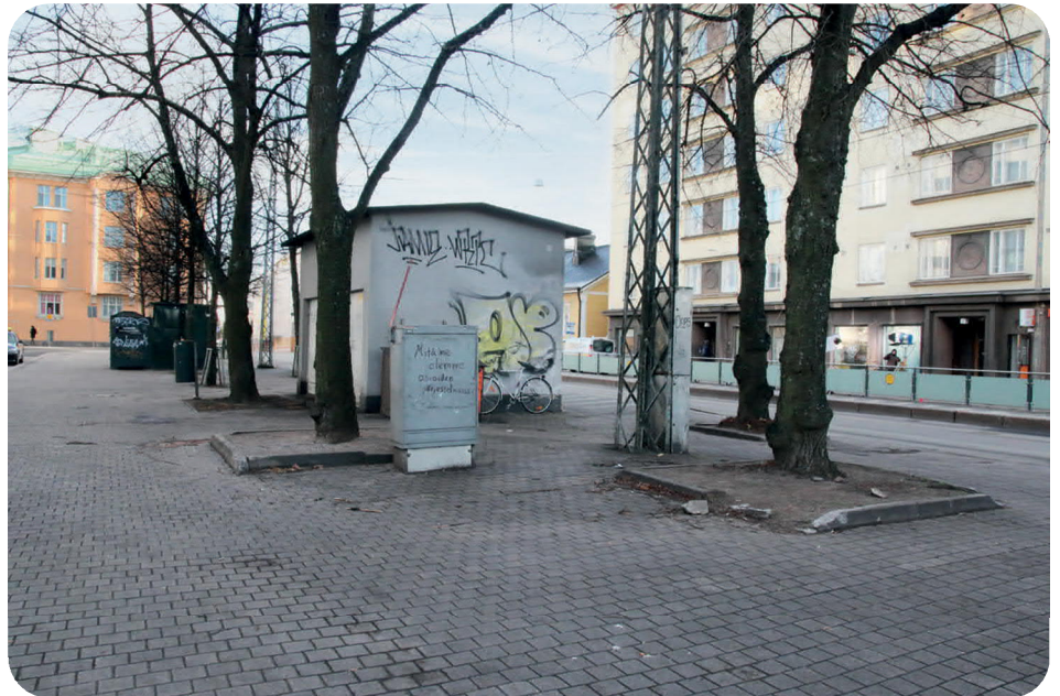
Kuva 79. Kuuskulman keskellä oleva jalankululle varattu tila on huonokuntoinen. Reunakivet ovat murtuneet ja lukuisat kunnallistekniset laitteet on tuhrittu. Suurin osa aukion lehmuksista on säilynyt.
