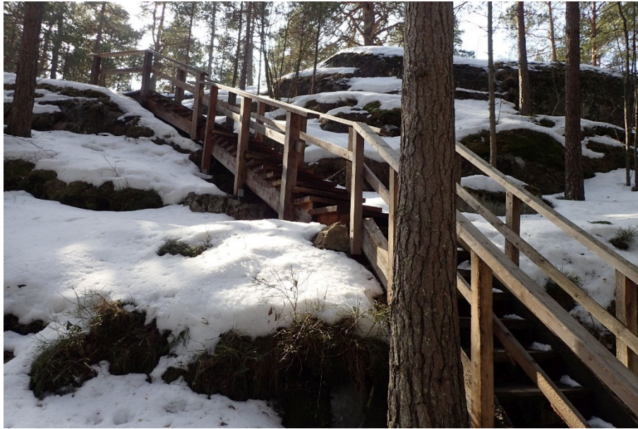
Kuva 11 Pohjoisosan portaat ovat uudehkot.
