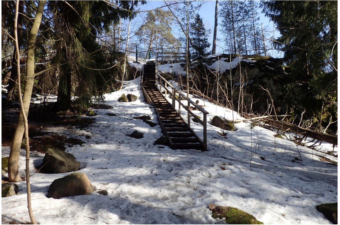
Kuva 27 Portaita on tarpeen huoltaa ja uusia myöhemmin tällä ohjelmakaudella. Kuva eteläisiltä portailta, oikealla näkyy kaivoskuilu.
