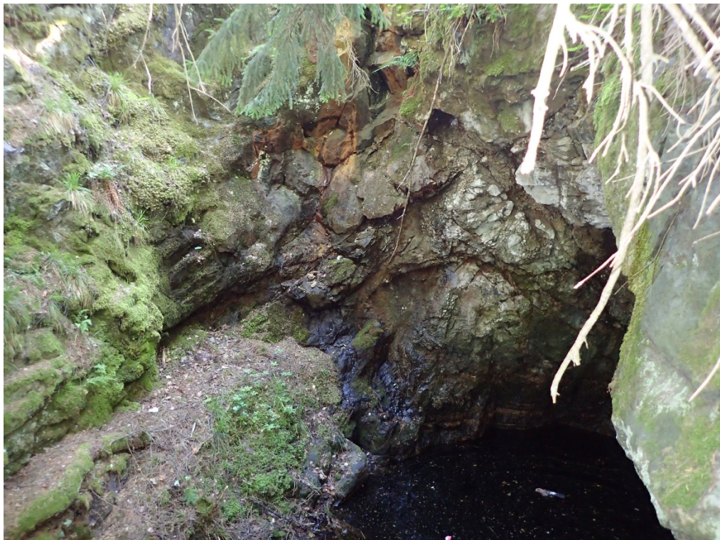
Kuva 21 Kaivoskuiluja puhdistetaan roskista ja suojarakenteiden kuntoa seurataan.
