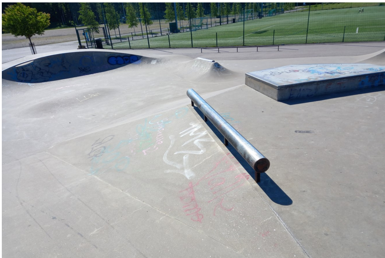
Kuva 6. Skeittipaikkojen betonielementteihin yhdistetään usein skeitattavuusominaisuuksien vuoksimetallia ja luonnonkiveä.
