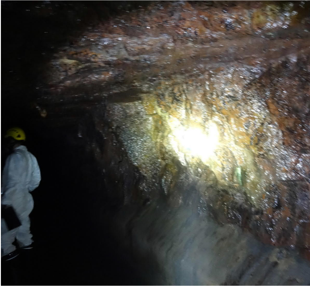
Kuva 22. Paaluväliltä 600-200 otettu kuva, jossa näkyy pääkivilajina olevaa graniittia. Tunnelin katossa erottuu selvästi vaaka- tai lähes vaaka-asentoinen rakoilu.
