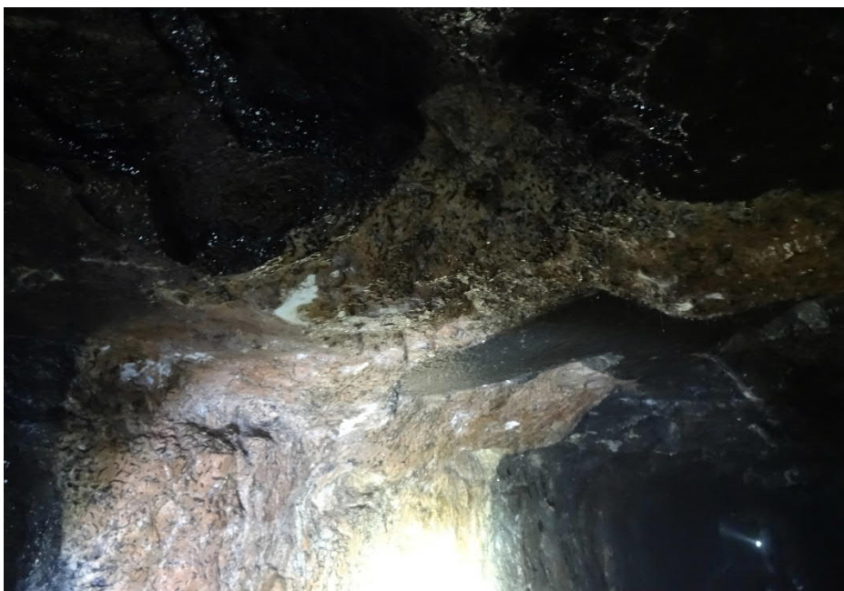
Kuva 16. Graniitti-pegmatiittijuoni tunnelin seinällä ja katossa paaluvälillä 1035-800. Kuva laskevan paaluluvun suuntaan.
