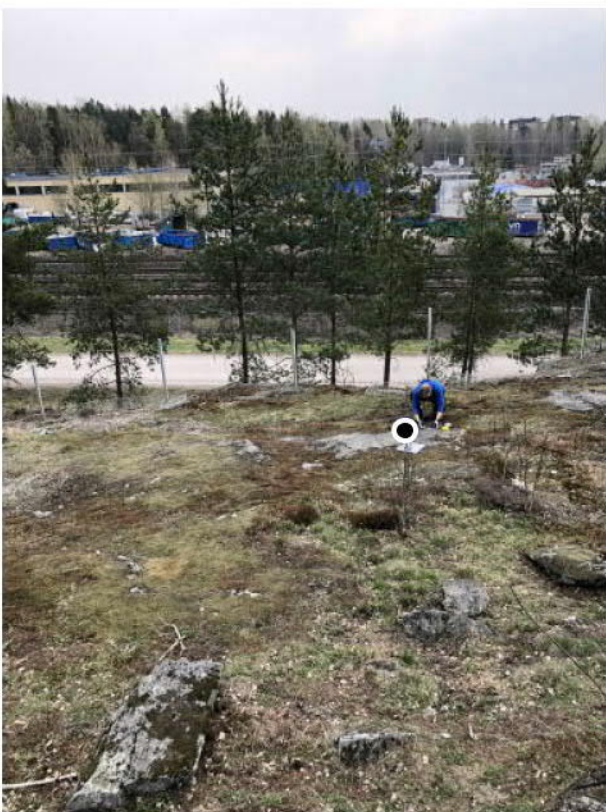
Kuva C5. Mittauspiste 3 avokalliolla tulevan liike-/asuinrakennuksen 3A lähellä. Kuvan ottohetkellä anturia ei ole vielä asennettu.
