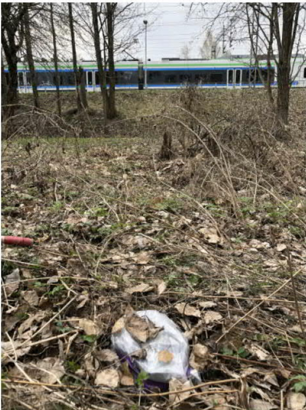
Kuva C2. Mittauspiste 1, lähikuva radalle. Maaruuvien varaan asennetut anturit on sadesuojattu muovilla.
