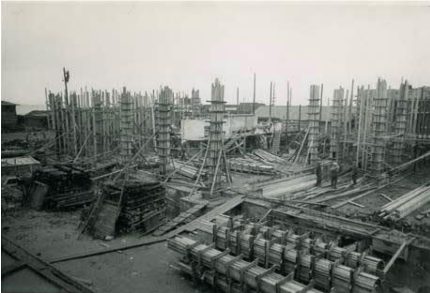
Kuva 3.5 Rakennuksen runkotyöt käynnissä, kuvassa betonipilareiden muotteja. MOBA
