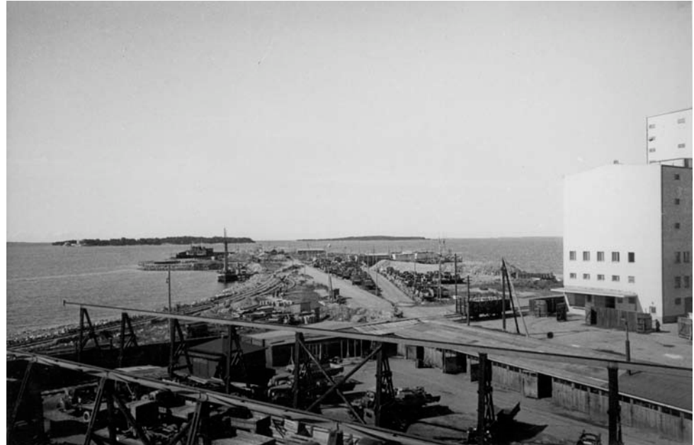
Kuva 2.4 Rakennuspaikka ennen tehtaan varsinaisten rakennustöiden aloittamista. Kuvassa oikealla vuonna 1936 valmistunut Munkkisaaren Mylly, jonka osti vuotta myöhemmin Vaasan Höyrymylly Oy. MOBA
