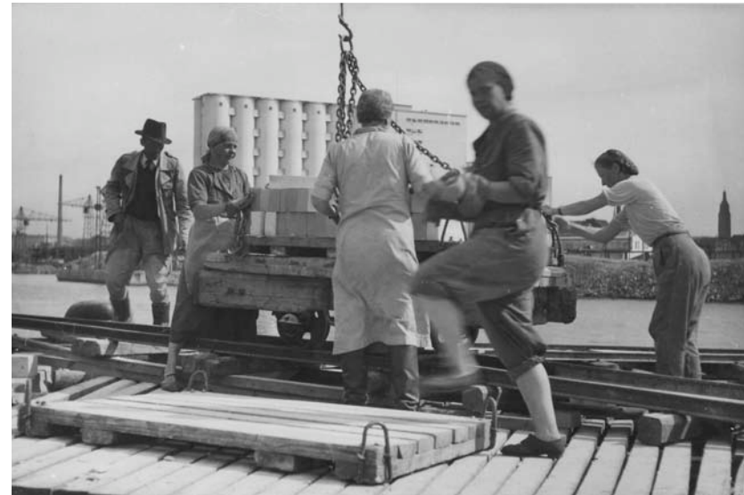
Kuva 3.9 Naisia rakennustöissä tehtaan työmaalla. MOBA
