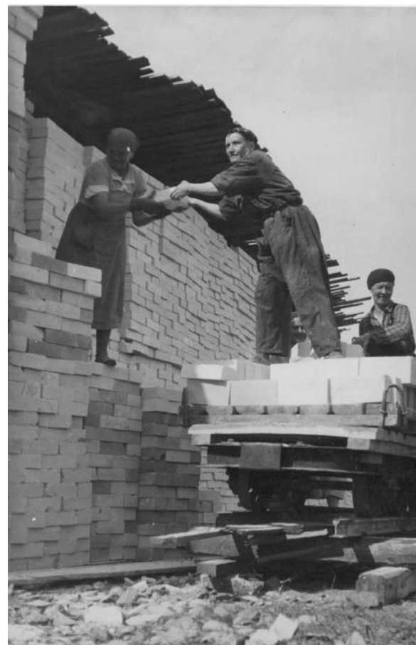
Kuva 2.5 Kalkkihiekkatiilien lastausta Fordin tehtaan työmaalla Hernesaarella. MOBA
