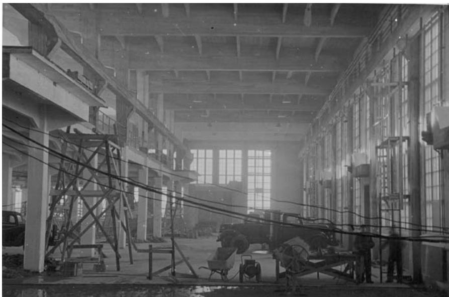
Kuva 3.10 Nosturihalli rakennustöiden aikana, näkymä kohti hallin eteläpäätyä. MOBA.
