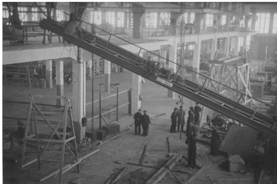
Kuva 3.11 Siltanosturia asennetaan paikalleen. MOBA.
