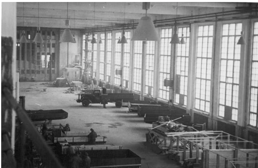
Kuva 3.12 Näkymä parvelta kokoonpanohalliin, kohti pääportaan ikkunaseinää. MOBA.
