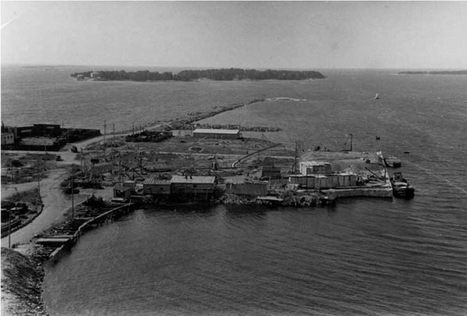
Kuva 2.3 Rakennuspaikka ennen tehtaan varsinaisten rakennustöiden aloittamista. Munkkisaaren laituri ja tontin täyttötööt ovat valmistuneet. Hernesaarenkarille on rakennettu pengeri, joten kuva lienee otettu vuoden 1935 jälkeen. Taustalla näkyy Pihlajasaari. FORD
