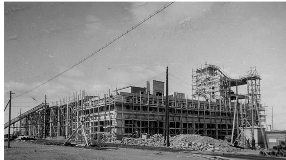
Kuva 3.8 Tehtaan työmaa. Torni nousee. FORD
