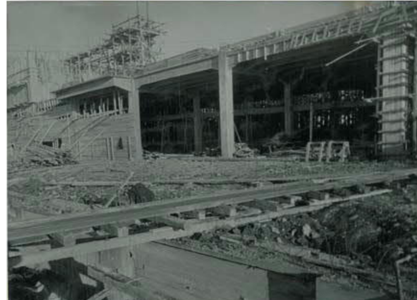
Kuva 3.6 Rakennuksen runko nousee. Tehdashallin keskiosan välipohja ja pilarit kuoriutu- vat lautamuoteista. MOBA
