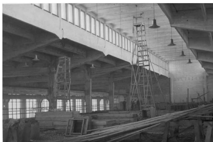
Kuva 3.13 Tehdashallin kattolyhty rakennustöiden loppuvaiheessa. MOBA.
