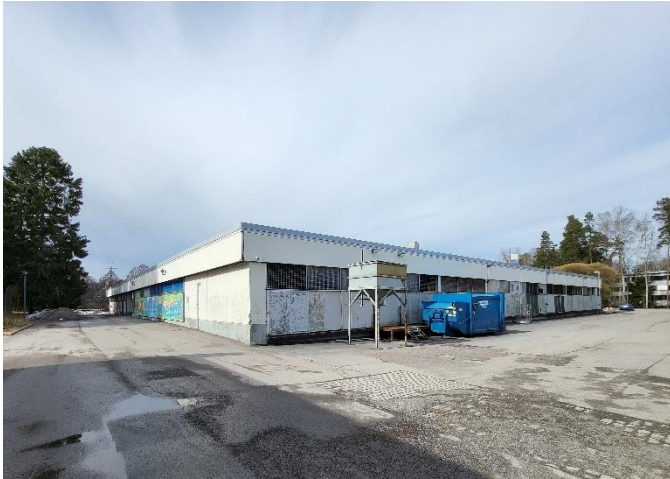
Rakennuksen julkisivua kaakosta katsottuna
