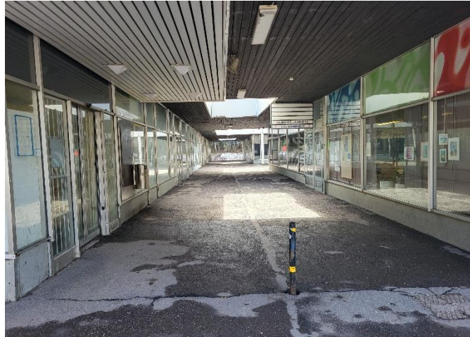
Rakennuksen keskellä sijaitseva ulkokäytävä
