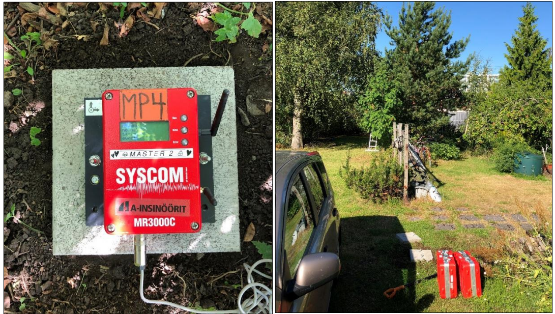
Kuva 5.3. Mittarit asennettiin maahan betonilaattoihin kiinnitettyinä.
