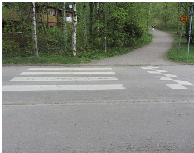
Puistoraitti ja korotettu suojatie eivät ole linjassa keskenään.
