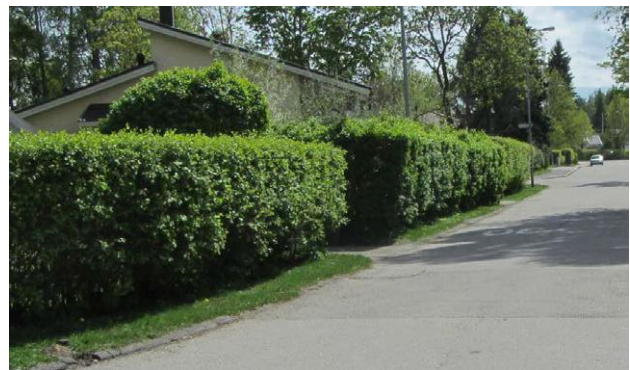
Reunatuen puuttumisen vuoksi hulevesiä valuu tontille Lähdepolulla.
