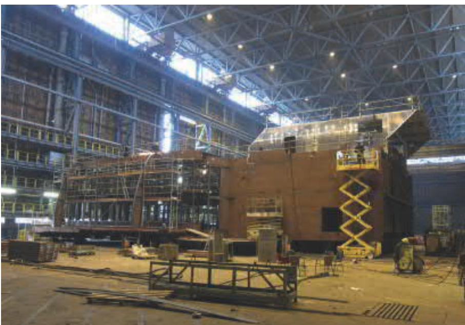
Laivalohkon työ Suurlokkohallissa 2011
