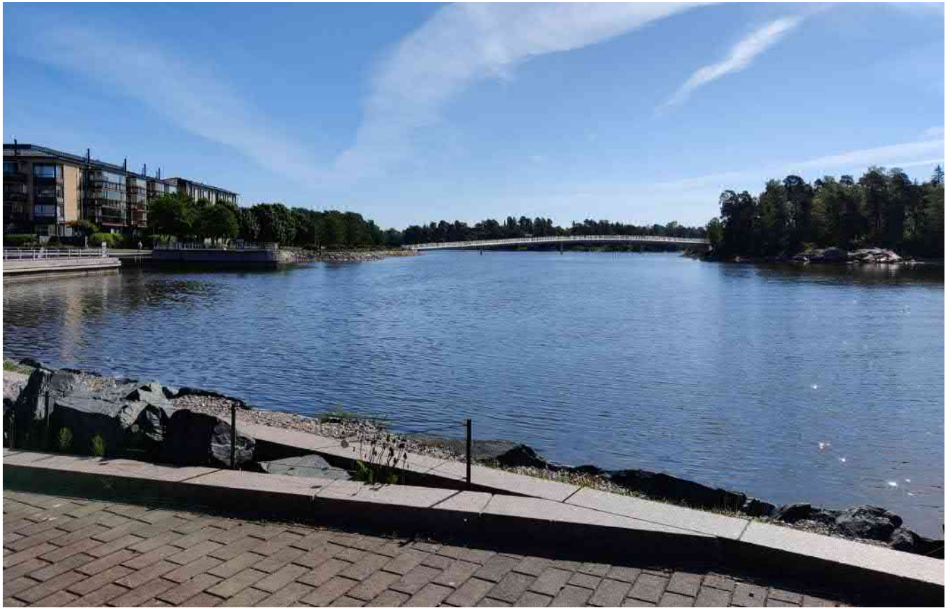
Kuva 22. Silta (VE1A) lännestä katsottuna.
