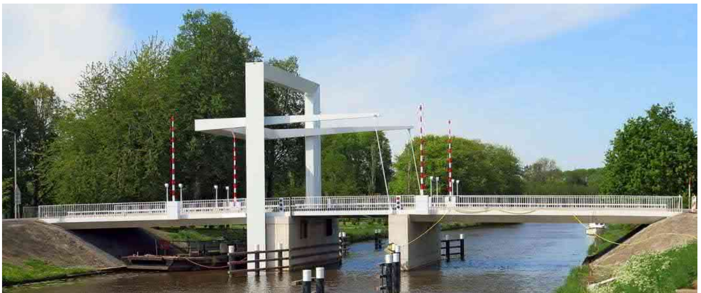
Kuva 30. Referenssikuva avattavasta sillasta (Lähde: < https://ipvdelft.com/projects/emmeloord-movable-bridge/ >).
