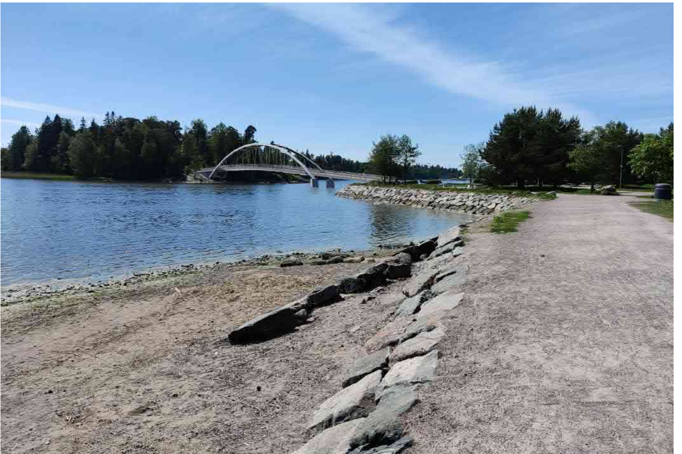
Kuva 26. Silta (VE1B) uimarannalta, idästä katsottuna.
