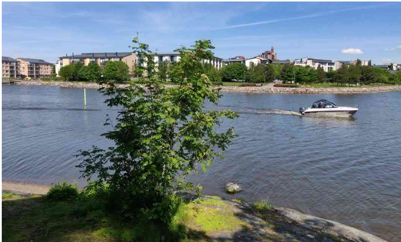
Kuva 20. Sillan Killingholman puoleinen rantakallio, johon siltarakenteella liitytään.
