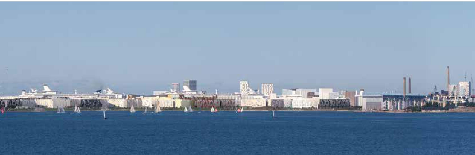
Näkymä Suomenlinnasta kohti Pihlajasaarta, Lauttasaarta ja Hernesaaren täyttöniemeä, Asemakaavoitus ja Tietoa Oy
