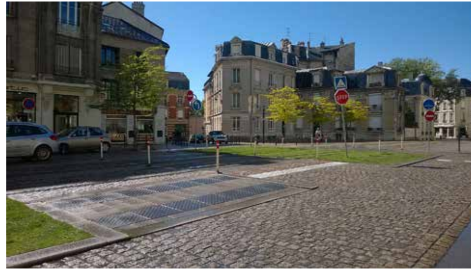
Kuva 23. Maanalainen sähkösyöttöasema, Reims
