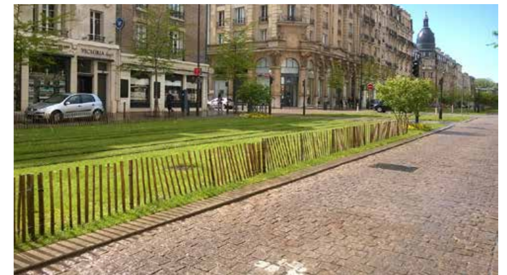
Kuva 76. Pintamateriaalina ruohorata ja kevyt aita erottamassa raitiotien kulku-uran muusta liikenteestä, Reims
