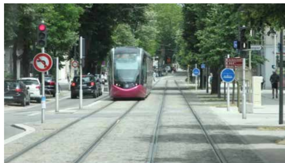
Kuva 75. Pintamateriaali osoittaa raitiotien kulku-uran, Dijon
