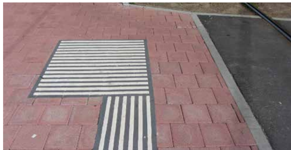
Kuva 81. Pintamateriaalin vaihdos ja näkövammaisten suunnistusta helpottavat huomioraidat raitiotiepysäkin yhteydessä
