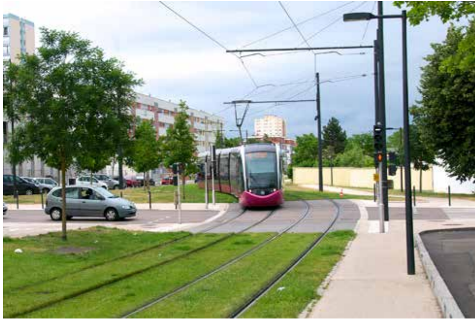
Kuva 24. Ajolankojen kiinnitys reunapylväissä, Dijon
