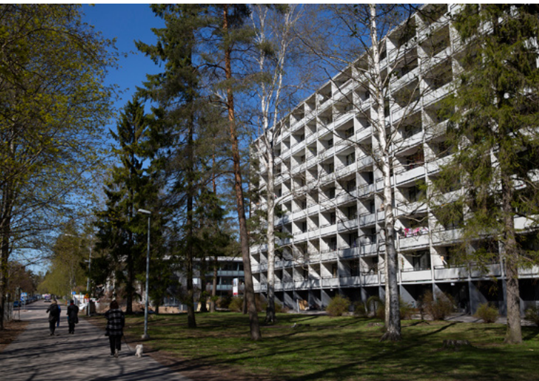
Lähiöiden rakentamisella vastattiin kaupungin kasvuun. Arkkitehti Lauri Silvennoisen suunnittelema Keinupolku 3 Kontulassa. Marja Väänänen / Helsingin kaupunki
