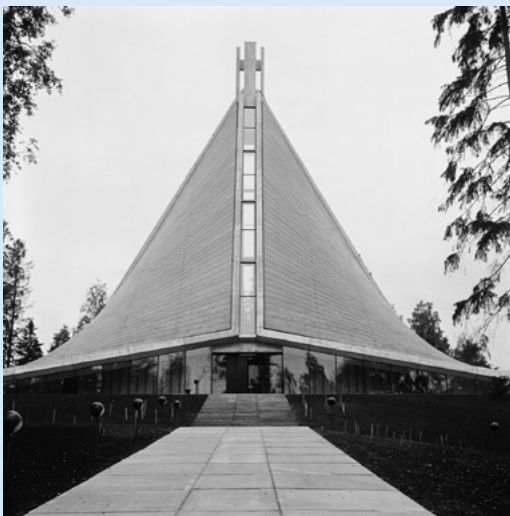
Kannelmäen kirkko edustaa 1960-luvun arkkitehtonisesti korkeatasoista ja teknisiltä ratkaisuiltaan ennakkoluulotonta uutta kirkkorakentamista.
