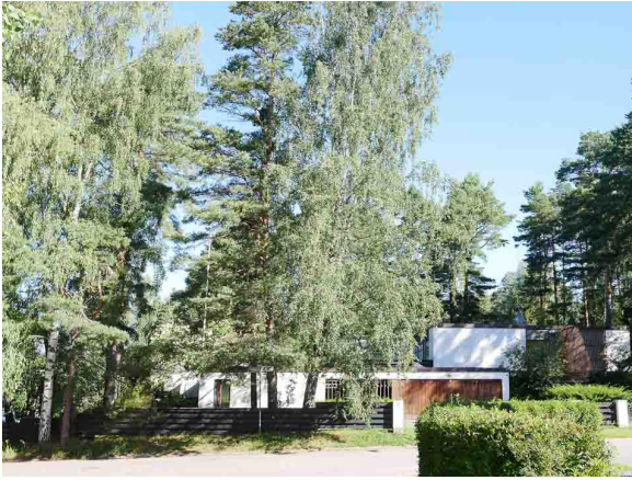
Kurkimoisio 8, katujulkisivu etelään (Kuva, Else Kyhälä)
