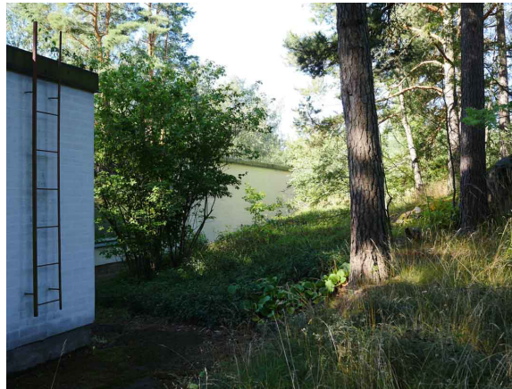
Kurkimoisio 8, Porrastuva julkisivu pohjoiseen (Kuva, Else Kyhälä)
