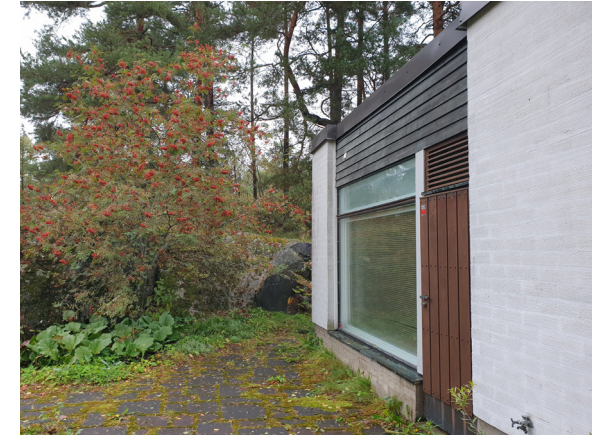
Kurkimoisio 8, päätyjulkisivu länteen ja avokalliota (Kuva, Jussi Ukkonen)
