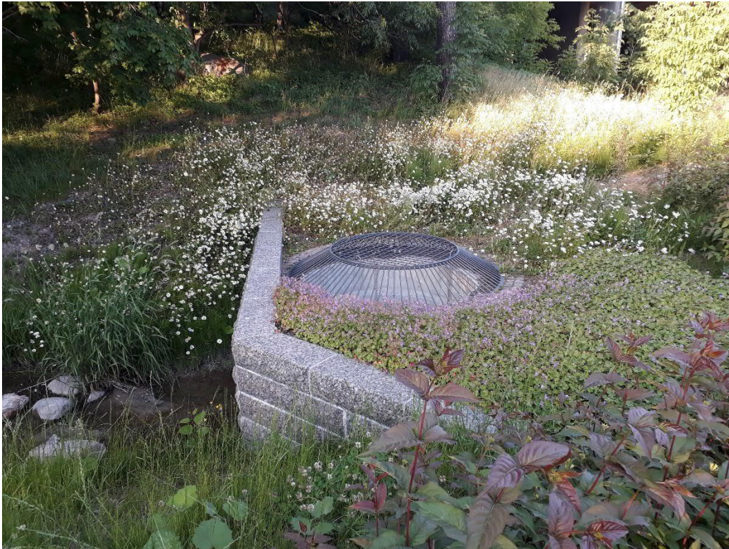
Kuva 10 Hulevesialtaan ylivuoto kupukansikaivolla (Terhi Renko)
