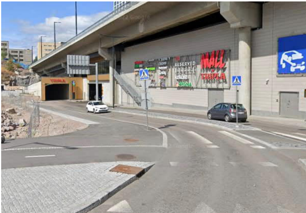
Kuva 9 Valokuva liikenneympyrän suunnasta, jossa näkyy sillan kannattajat sekä olemassa olevan rakennuksen rakenteita (Google Maps, 2021)
