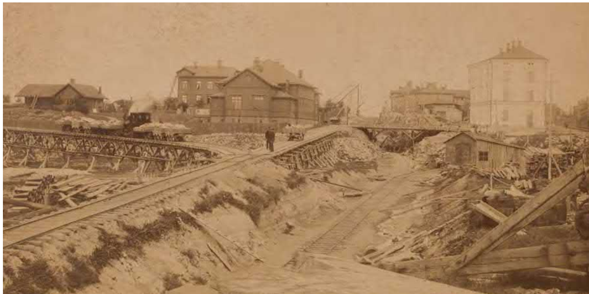
Satamaradan työmaa Leppäsuon kohdalla vuonna 1905. HKM
