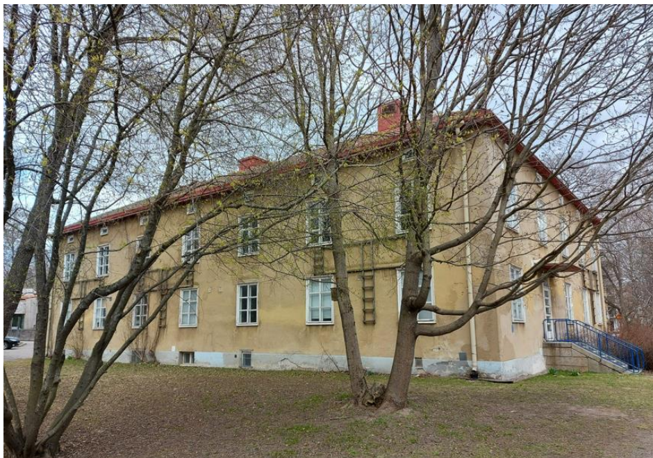
Kuva: Rakennuksen kaupunkitilallisesti merkittävimmät julkisivut puiston suuntaan (vasemmalla) sekä Laajalahdentien suuntaan (oikealla). Helsingin kaupunki, 2022.
