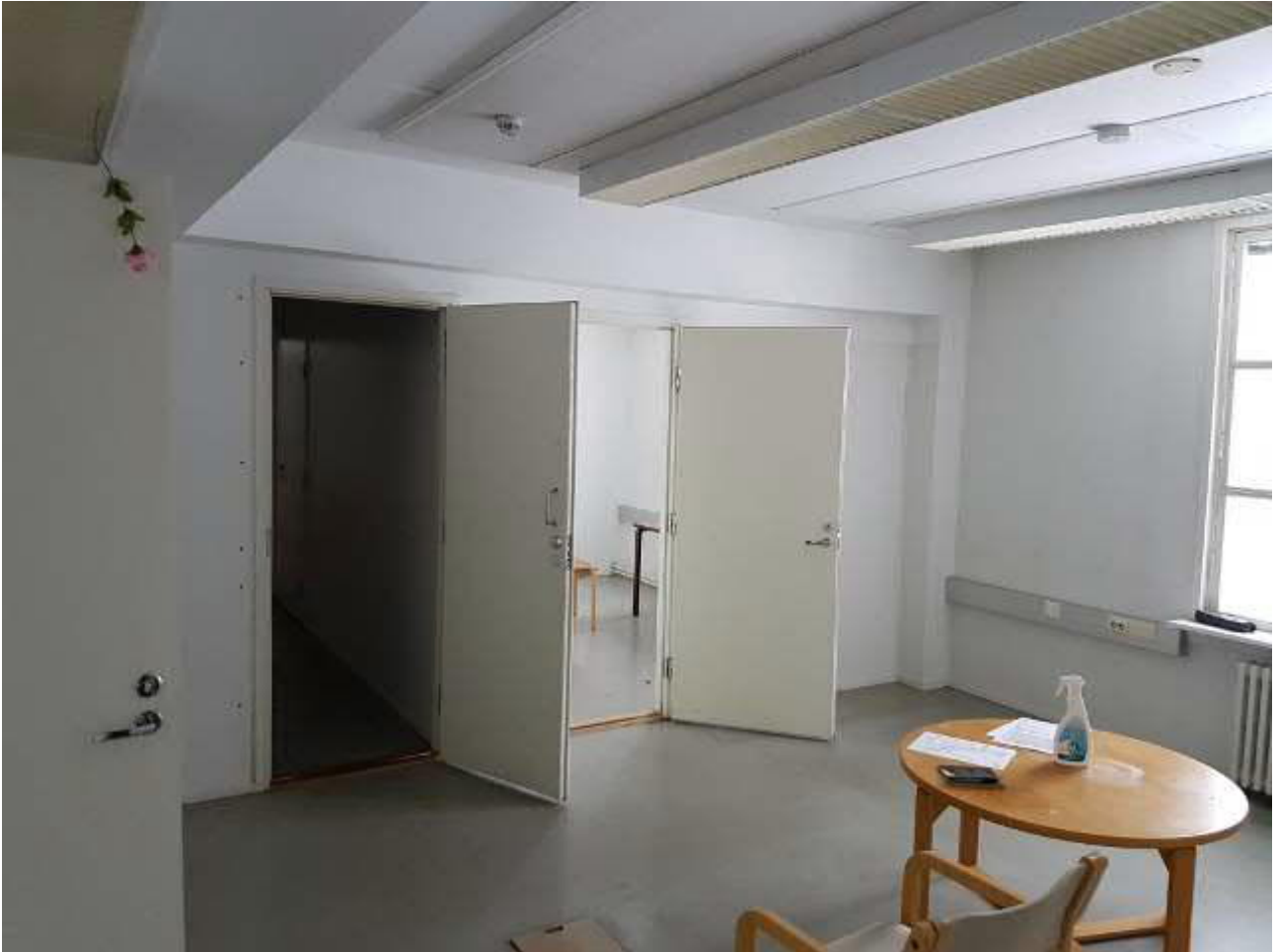
Ensimmäisen kerroksen vanhan kirkkoherranviraston toimistotiloja. Sisäovet ovat pääosin maalattuja laakaovia peruskorjauksen ajalta. Lattiapinnat ovat kuluneita. Helmikuu 2017.
