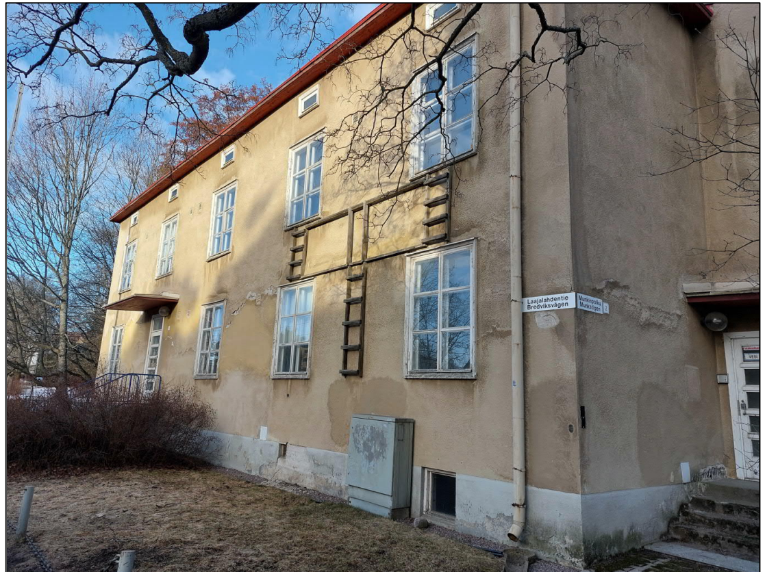
Kuva 1.2. Rakennuksen julkisivua Laajalahdentien puolelta.
