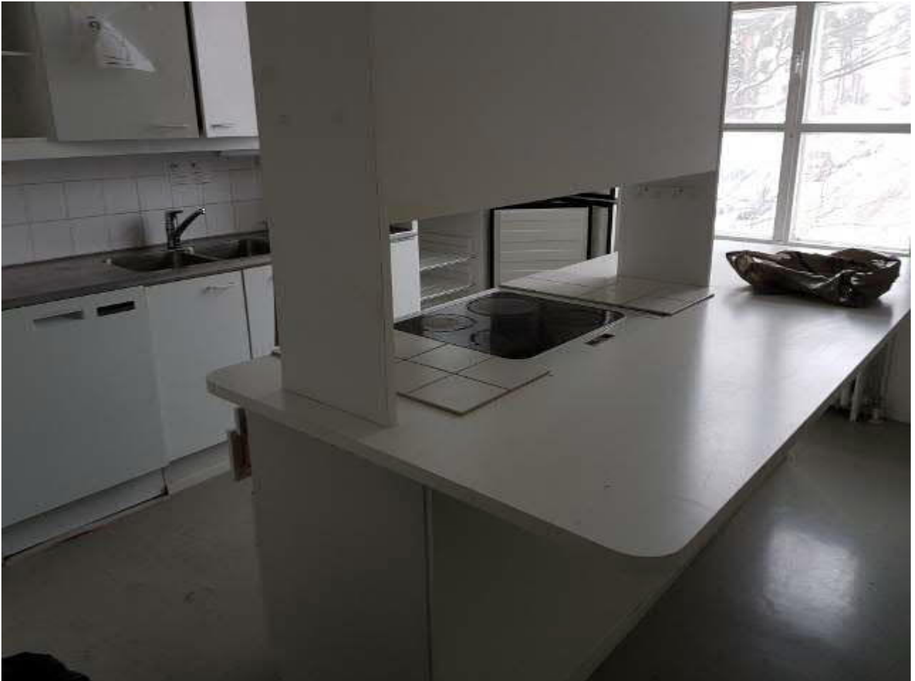
Toisen kerroksen opetuskeittiön kalusteet ja laitteet ovat kuluneita, mutta toimivia. Helmikuu 2017.
