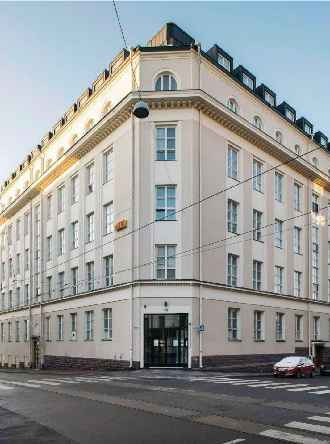
Kuva 2. Ruoholahdenkatu 23:n rakennuksen pääsisäänkäynti Ruoholahdenkadun ja Köydenpunojankadun risteyksessä. (Kuva: Niclas Mäkelä/Nomad Arkkitehdit Oy)
