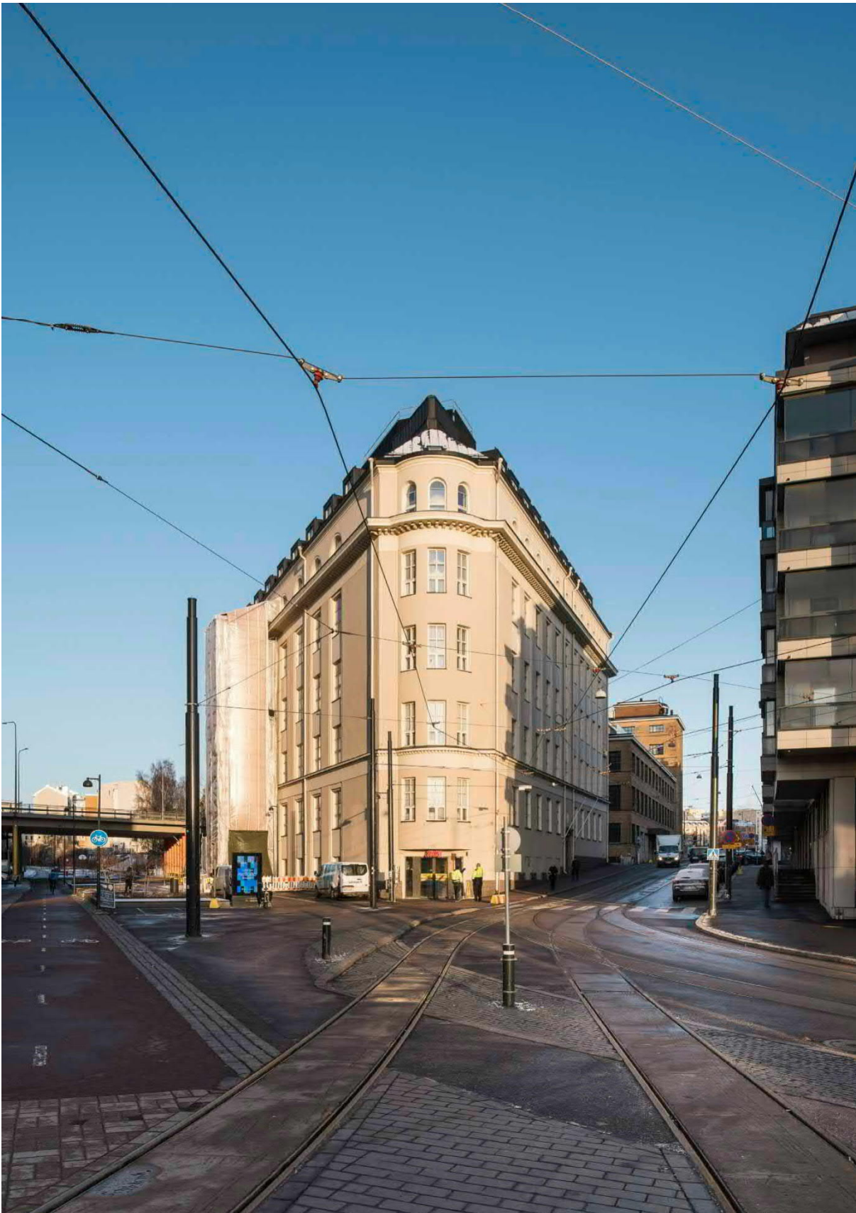
Kuva 3. Ruoholahdenkatu 23:n rakennus Ruoholahdenkadun ja Baanan risteyksestä kuvattuna. (Kuva: Niclas Mäkelä/Nomad Arkkitehdit Oy)
