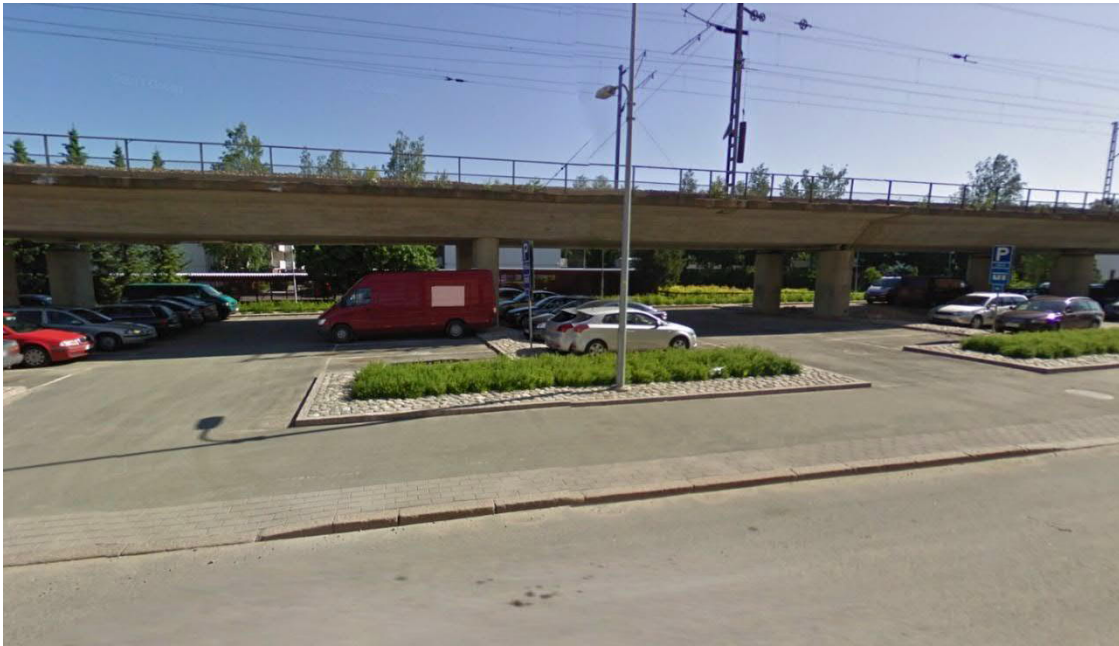
Kuva 3: Kehärata on perustettu pilareiden päälle tontin kohdalla. Pilariparin etäisyys toisesta pilariparista on noin 18 m. Kuva: Google Maps, Street View 17.12.2019
