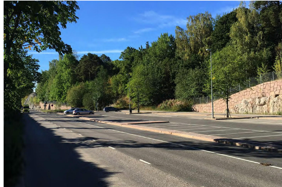
52. Näkymä pohjoisesta kohti tunnelin suuaukkoa (kuva: B&M Oy)
