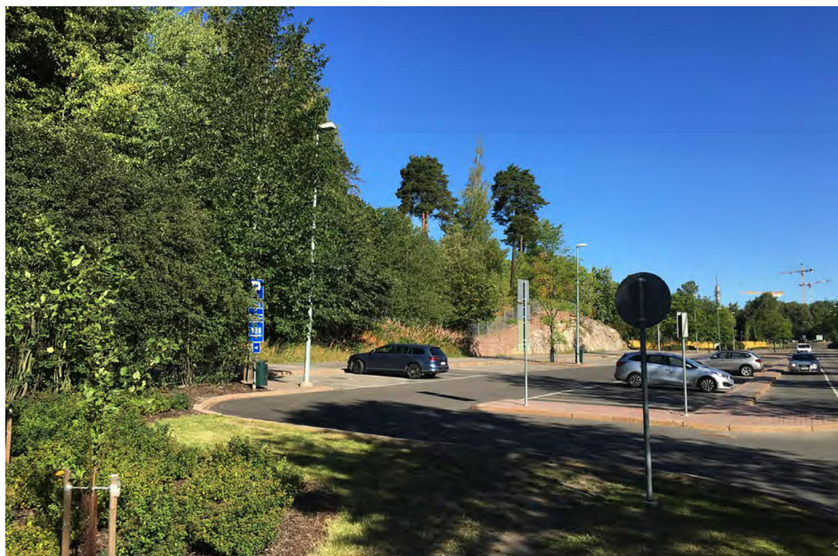
53. Näkymä etelästä kohti tunnelin suuaukkoa (kuva: B&M Oy)
