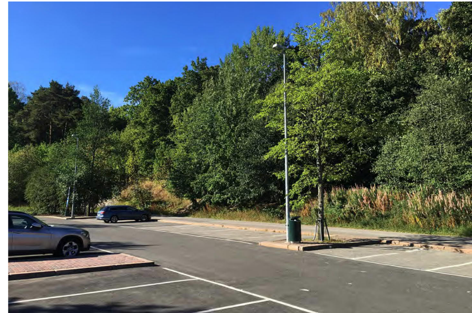
54. Lähinäkymä pohjoisesta kohti tunnelin suuaukkoa (kuva: B&M Oy)
