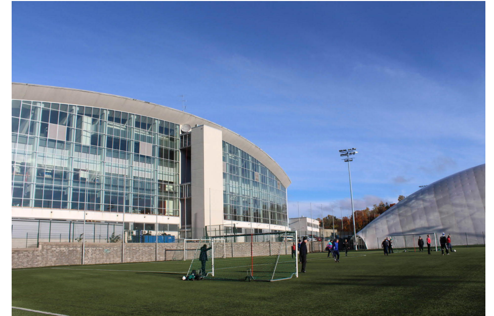
23. Näkymä kohti Jäähallin eteläpuolelta koilliseen
