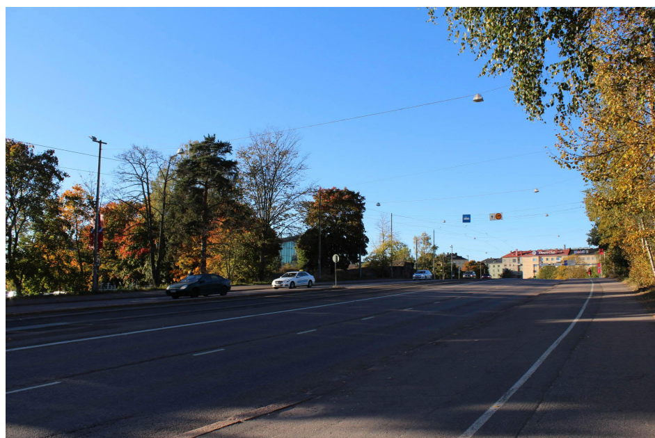
9. Näkymä Nordenskiöldinkadun bussipysäkiltä kohti Jäähallia
