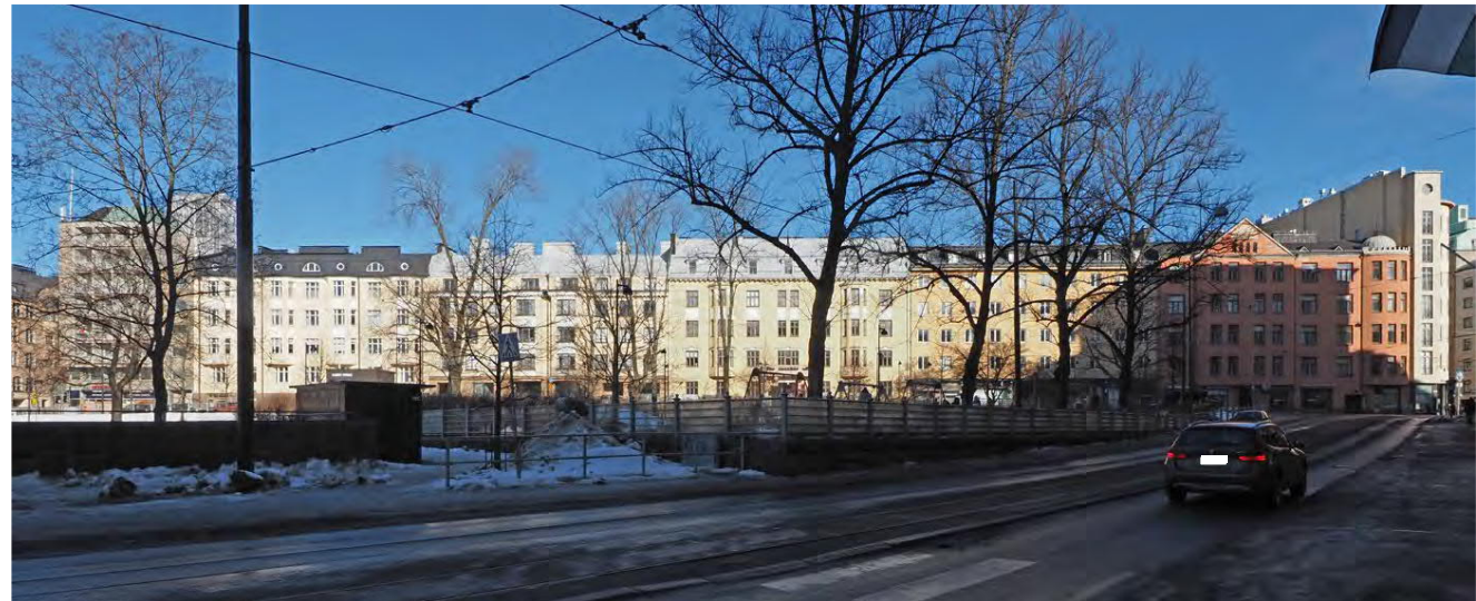
Alla: Lapinlahdenkadun julkisivurintama. Kuva: Sakari Mentu
