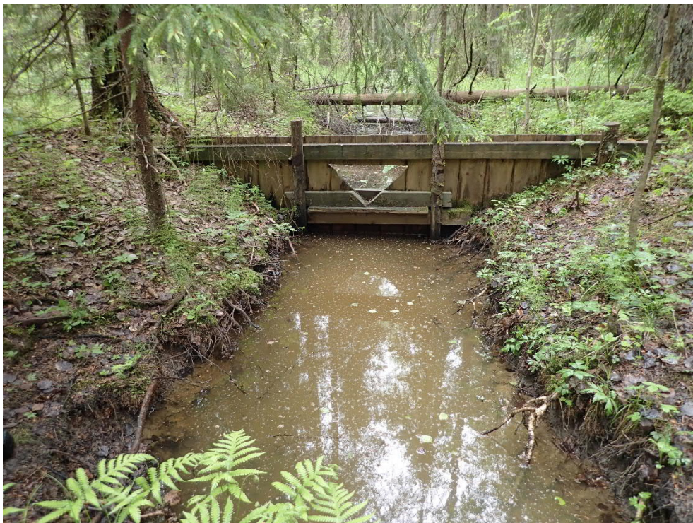
Kuva 26 Levypadoilla on säännöstelty ennallistamisalueen veden liikumista.
