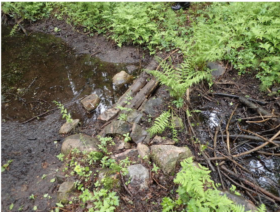
Kuva 24 Purouomaa on ennallistettu pienellä hidastepadolla.
