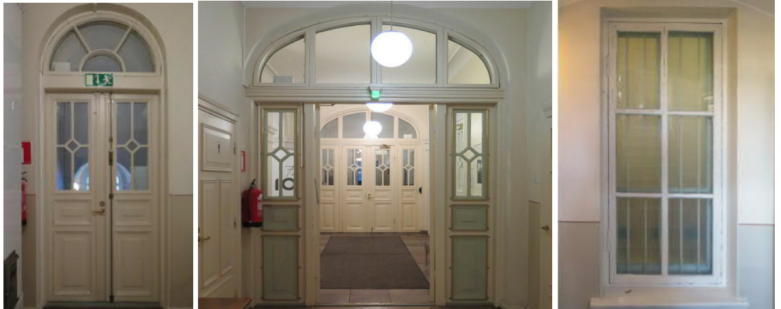
Mariankatu 23:n lasiväliseiniä ja väliseinäikkunnoita
