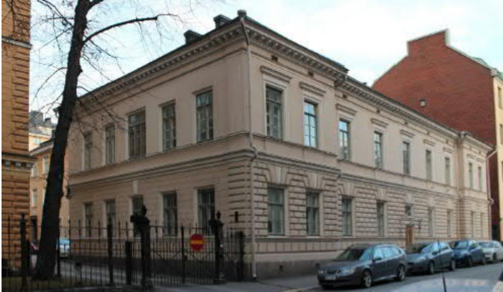
Maneesikatu 7:n katujulkisivu
