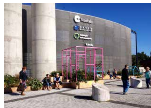
Liikuteltavat istutus- ja oleskeluaiheet tarjoavat pysähtymisen paikan aurinkoisella julkisivulla, avoimen tilan reunassa
