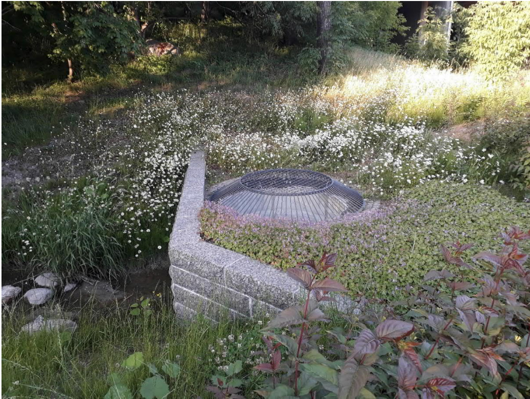
Kuva 10 Hulevesialtaan ylivuoto kupukansikaivolla (Terhi Renko)
