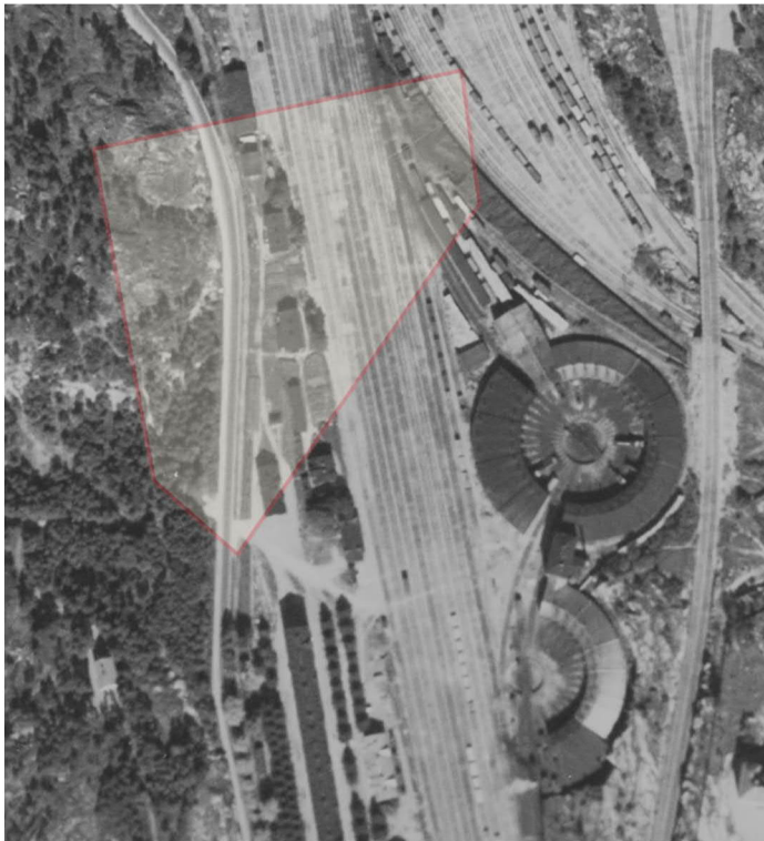
Kuva 2. Vuonna 1932 alueella on havaittavissa ratapihan rakenteet (Maanmittauslaitos).
