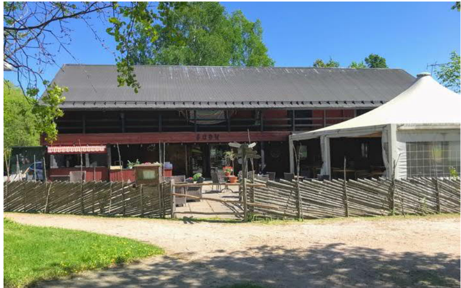
Kuva: Helsingin kaupunki, asemakaavoitus. Tervasaaren aitta ja siihen liite lisärakennelma vuonna 2018.
