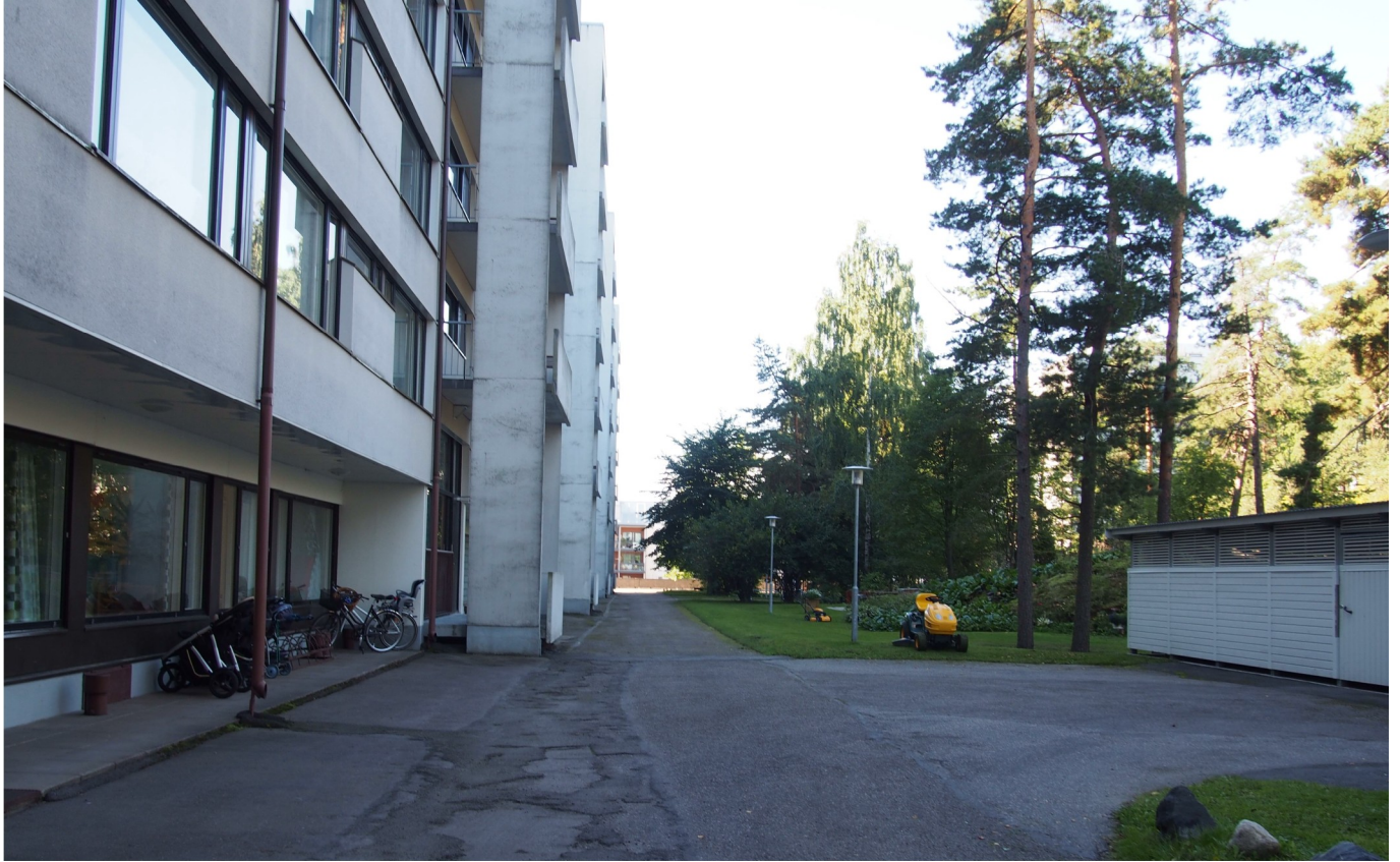
Näkymä länteen pohjoista julkisivua pitkin.
