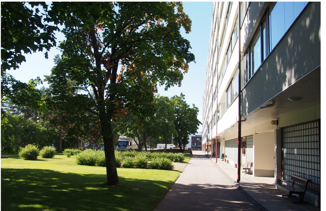
Näkymä länteen eteläistä julkisivua pitkin.
