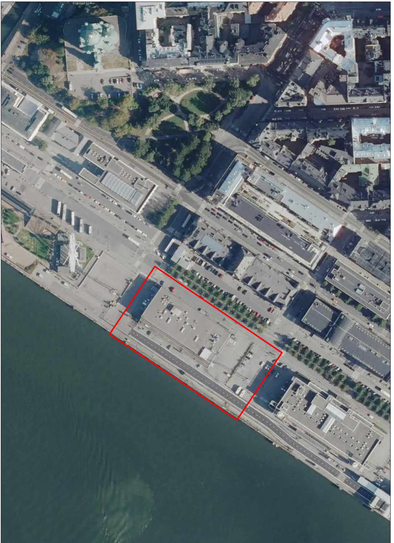
Ilmakuva Katajanokka, Katajanokanlaituri 4
