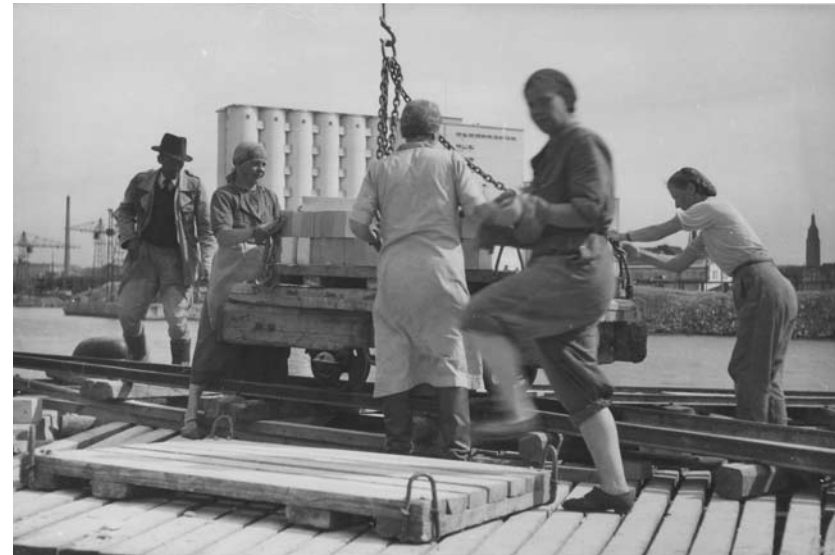
Kuva 3.9 Naisia rakennustöissä tehtaan työmaalla. MOBA
