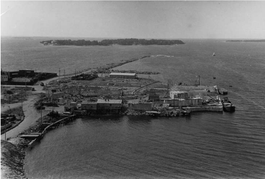
Kuva 2.3 Rakennuspaikka ennen tehtaan varsinaisten rakennustöiden aloittamista. Munkkisaaren laituri ja tontin täyttötyöt ovat valmistuneet. Hernesaarenkarille on rakennettu pengeri, joten kuva lienee otettu vuoden 1935 jälkeen. Taustalla näkyy Pihlajasaari. FORD
