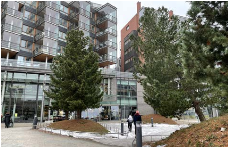
Kummut puineen luovat miellyttävän tilan
