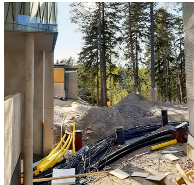
Säilytettyä puustoa Viikinmäen rakennustyömaan reunassa.
