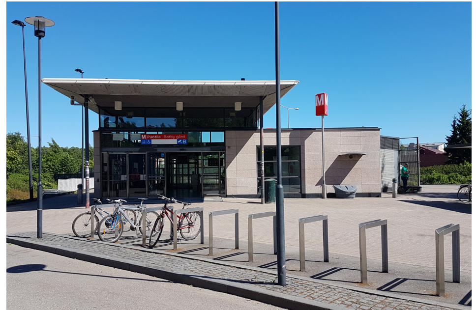
Puotilan metroaseman pohjoinen lippuhalli.
