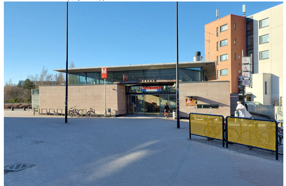
Puotilan metroaseman pohjoinen lippuhalli.
