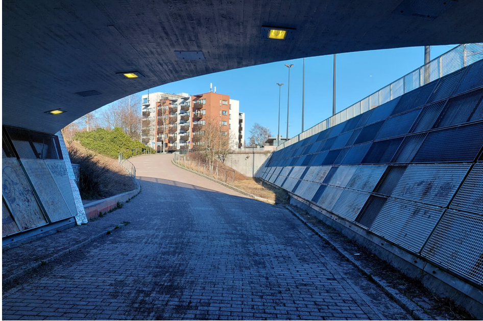
Itäväylän alikulku ja metroaseman ulkoseinä.
