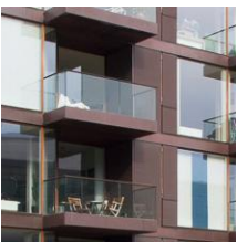
Julkisivumateriaalina tumma metalli
