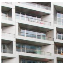
Parvekevyöhykkeet hahmotuvat osana rakennusmassaa
