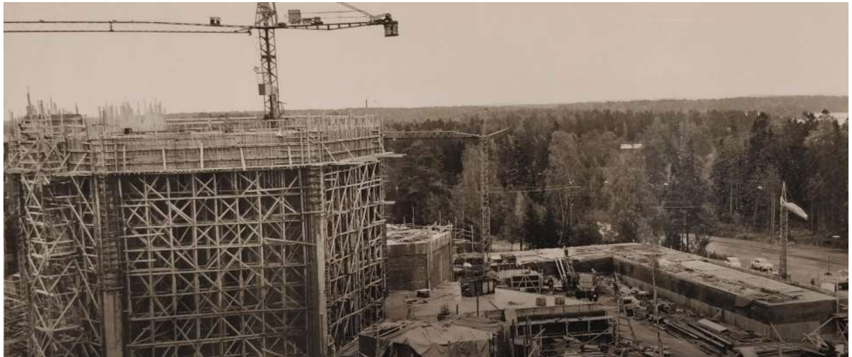
Kuva 27: Kirkko ja seurakuntasiipi rakenteilla
