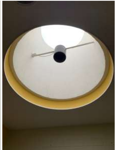
Kuva 119: Kattoikkuna toimistosiiven päässä
