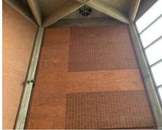
Kuva 98: Akustinen tiiliverhous
