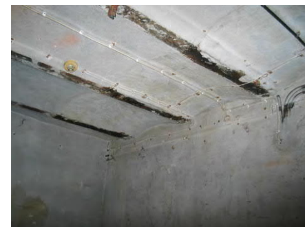
Kellarivälipohjan alkuperäiset kappaholvit
