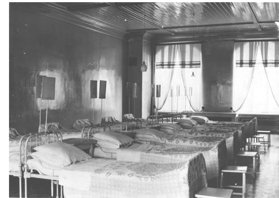
Toisen kerroksen 12 hengen potilashuone, jonka nurkassa näkyy ilmanvaihtohormi ritiläaukkoineen. Kuva n. 1900, Sotamuseo.
