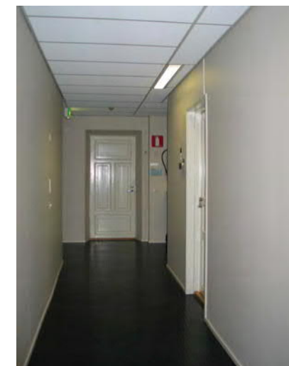
Uusi toimistokäytävä alaslaskettuine kattoineen
