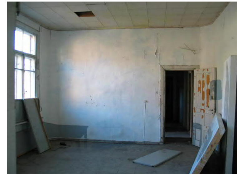
Eristysrakennuksen rapatut hirsiseinät pyörästettyine sisänurkkineen. MSKS 2007
