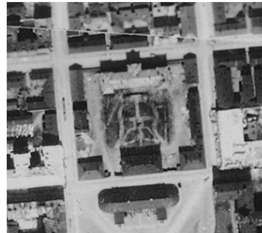
Sairaala-alueen pihan jäsentely puutarhoineen erottuu selvästi 1920-luvun ilmakuvasa (1924, HKM N62440).
