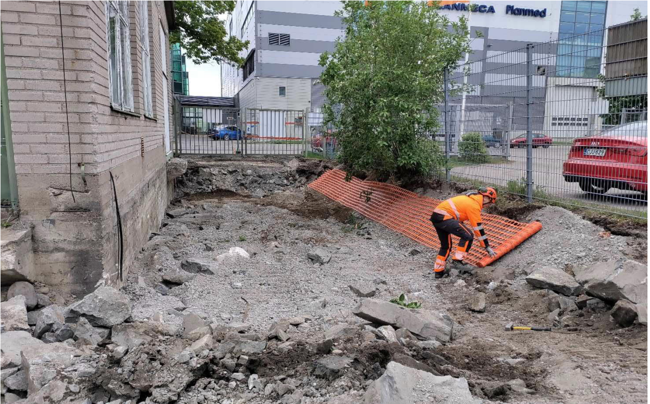
Kuva 6. Huomioverkon asennus tontin eteläreunalle
