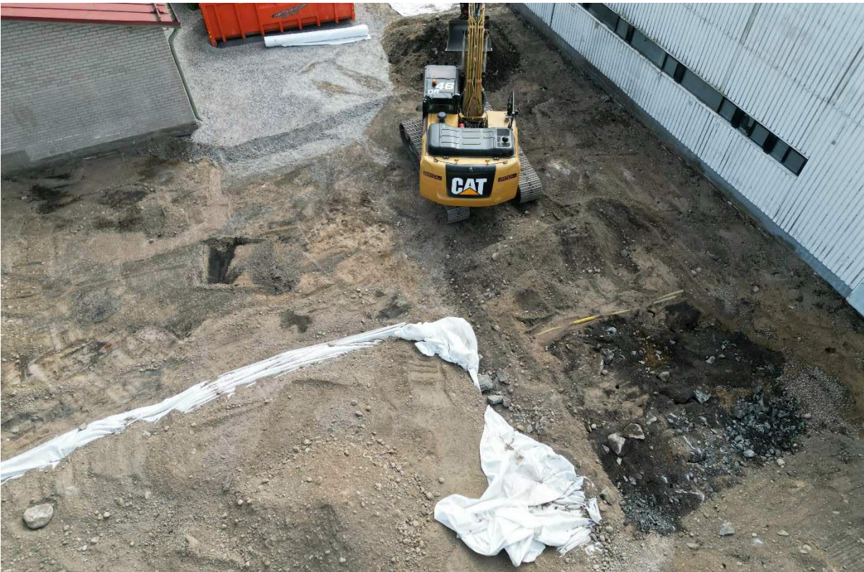
Kuva 8. Tontin keskialueen kunnostusta. Tumma kerros erottuu puhtaan pintakerroksen alta.
