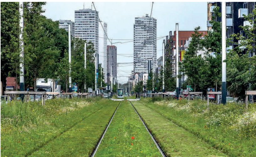
Runsasta ja hyvin suunniteltua niittyraidetta Paris-Orly raitiotiellä. Kuva: Länsi-Helsingin raitiotien Design Manual
