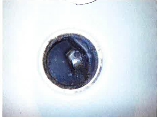
Asunnon kylpyhuoneen lattiakaivo.
