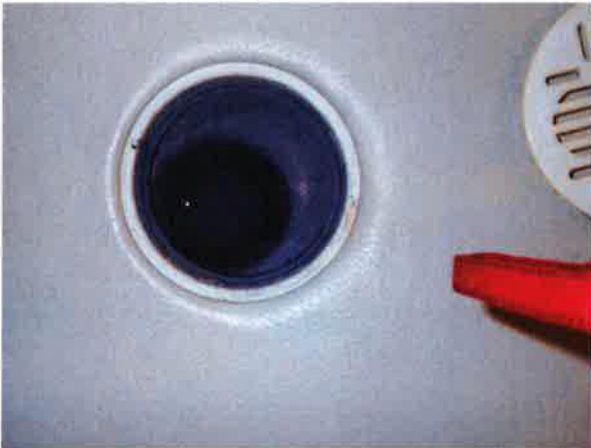
Asunnon kylpyhuoneen lattiakaivo.
