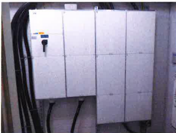
Kiinteistön sähköpääkeskus.
