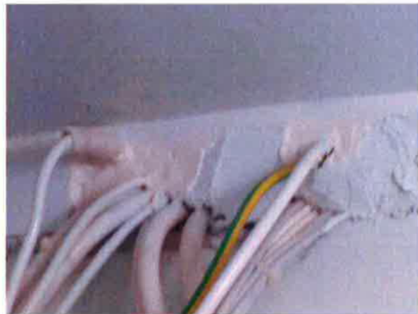
Sähkökeskushuoneen paloläpivienti.
