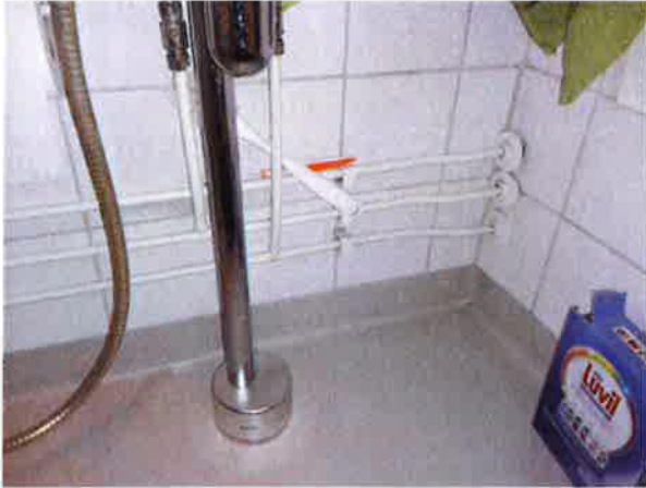
Asunnon käyttövesiverkoston kytkentöjä.
