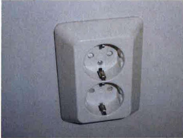
Maadoitettu pistorasia eteisessä.
