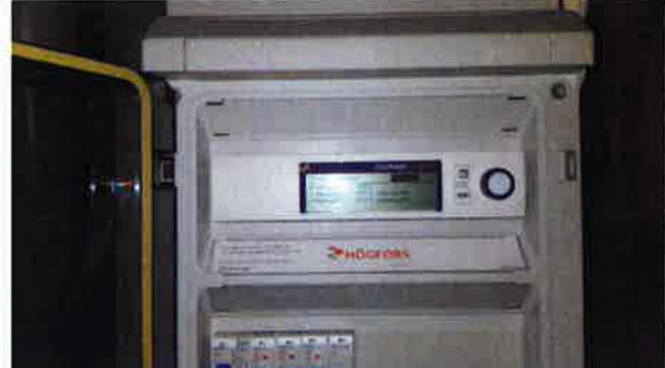
Alajakokeskuksen yksikkösäädin.
