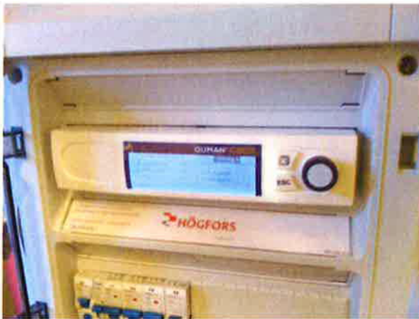
Paikallissäädin.
