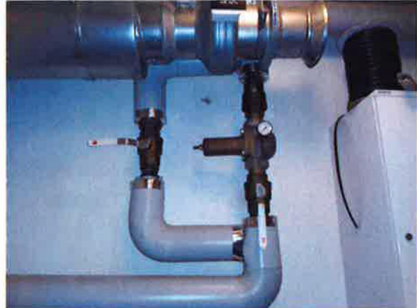
Vakiopaineventtiili lämmönjakohuoneessa.
