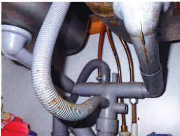
Yleiskuva astianpesukoneen poistoputken kiinnityksestä.
