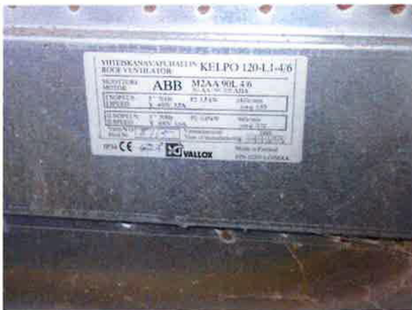
Yleiskuva huoneistoja palvelevan yhteiskanavapuhaltimen tyyppikilvestä.
