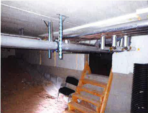
Yleiskuva viemäriverkostosta alustatilassa.
