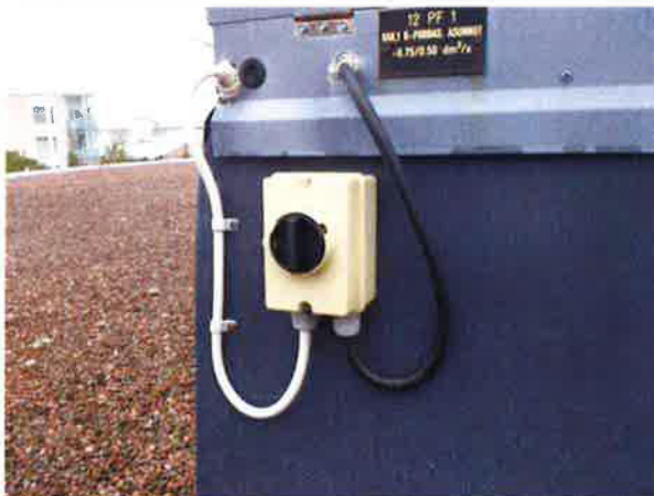
Poistopuhaltimen sähköistys.
