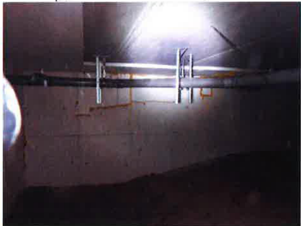
Yleiskuva viemäriverkostosta alustatilassa.
