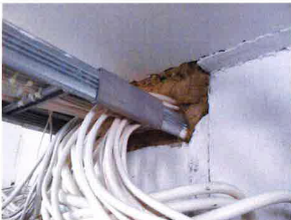
Sähkökeskushuoneen paloläpivienti.
