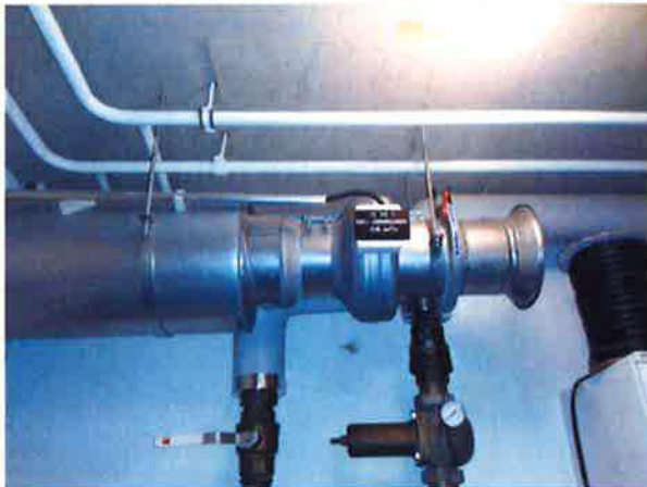
Lämmönjakohuoneen poistopuhallin.
