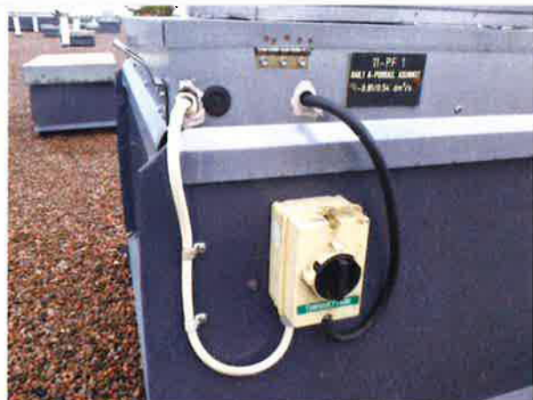
Poistopuhaltimen sähköistys.
