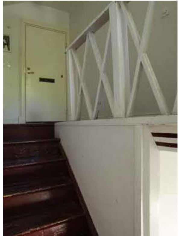
↑ Porrashuone vuonna 2020. Tilajäsensely on säilynyt, aiemmin puupaneloituja pintoja on levytetty umpeen.
