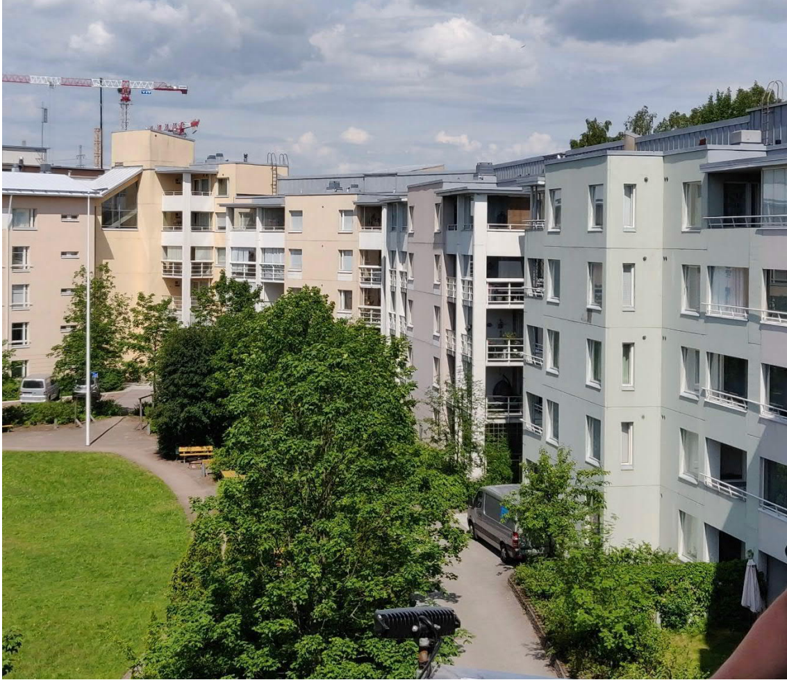
Kuva 17. Yleiskuva sisäpihalta. Lähes ulkoseinässä kiinni olevat kasvit suositellaan poistettavaksi.
