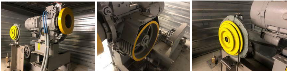
Kuvia: nostokoneistoista, vetopyörästä, kannatusköysistä ja nopeudenrajoittajasta
