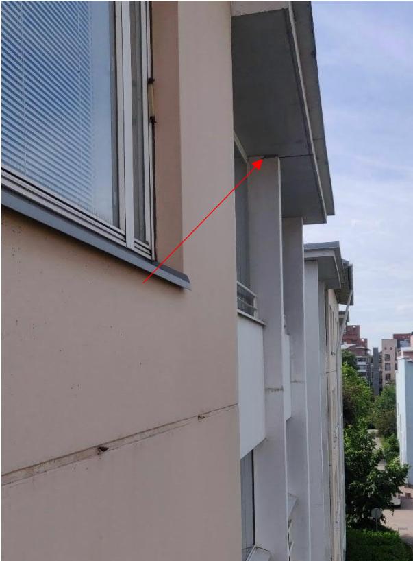
Kuva 16. Parveketornin ylimmän kerroksen pieli/välilementin yläreunassa havaittavissa paikallista rapautumaa.
