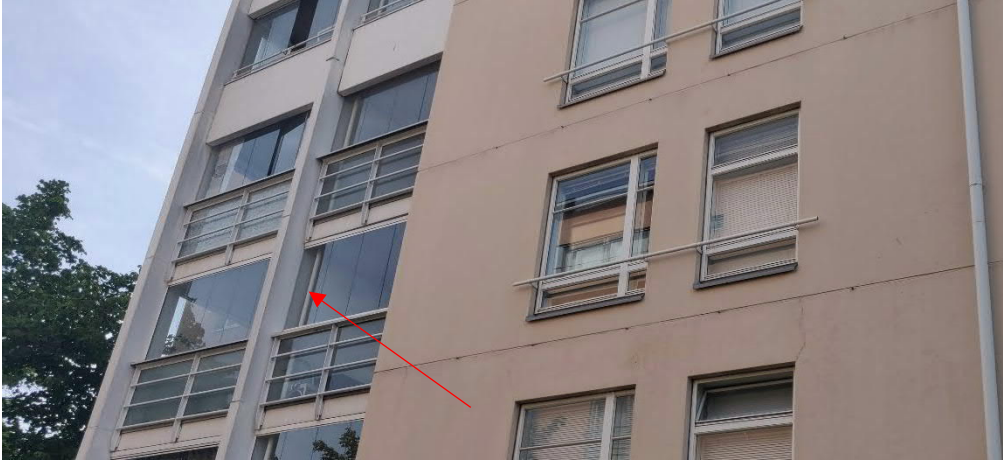
Kuva 15. Nuolella osoitettu parvekkeiden vedenpoisto on toteutettu putkijärjestelmänä.
