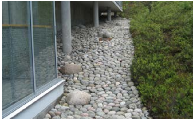
Kuva 6. Rakennuksen vastakaato ja hulevesiuoma luonnonkivistä. Henrik Lättiläisen katu 8 (LOCi)
