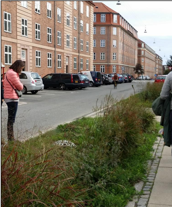
Kuva 35. Esimerkki katualueen biosuodatusrakenteesta Kööpenhaminassa (kuva Karoliina Sulonen).
