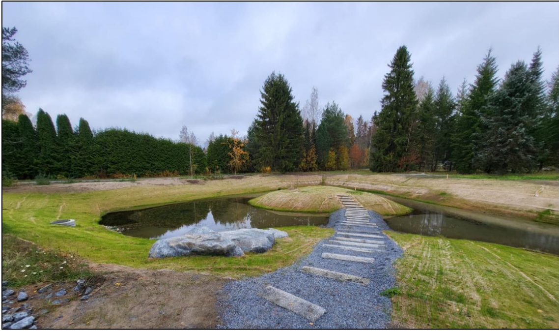
Kuva 34. Ikurin Taimiston lähes valmistunut monitavoitteinen hulevesiallas (kuva Olli Nissinen). Altaan pinta-ala on noin 1800 m 2 ja pysyvän vesitilavuuden lisäksi altaassa on noin 500 m 3 viivytystilavuutta.
