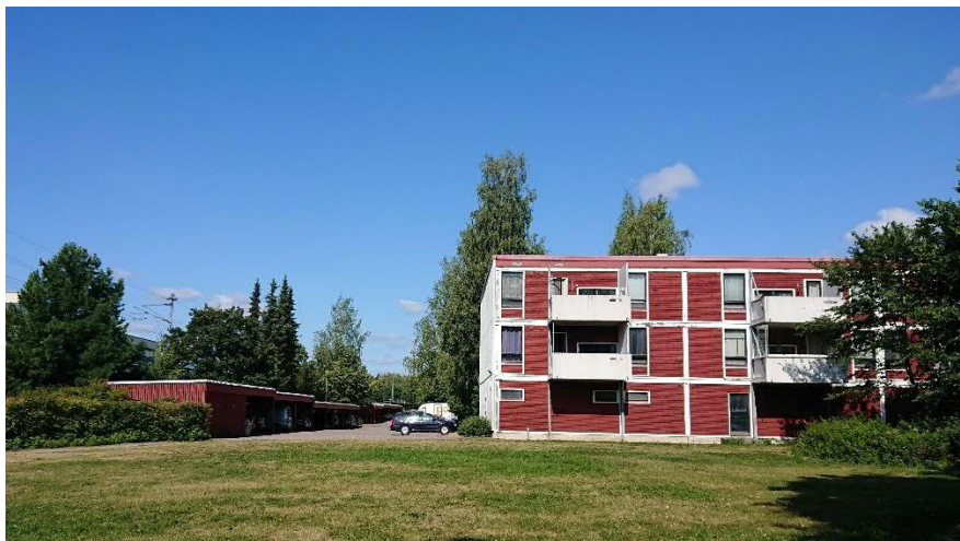
Pasuunakuja 1:n matalampi, kolmekerroksinen lamellitalo ja autokatos idästä Soittajanpolulta.
