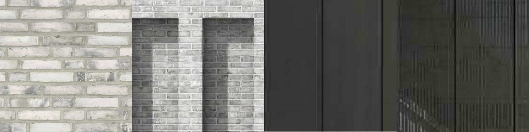
1. PAIKALLA MUURATTU TIILI Petersen Tegel Mursten D91 (228x108x40mm) Harmaa muurauslaasti
