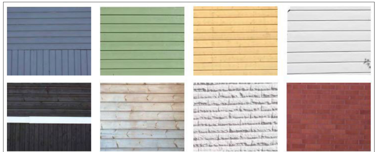
Kuva 18. Esimerkkejä julkisivumateriaaleista ja -väreistä.
