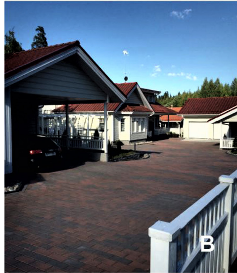
Pihat on päällystetty erilaisin läpäisemätömin materiaalein, esim. asfaloitu.
