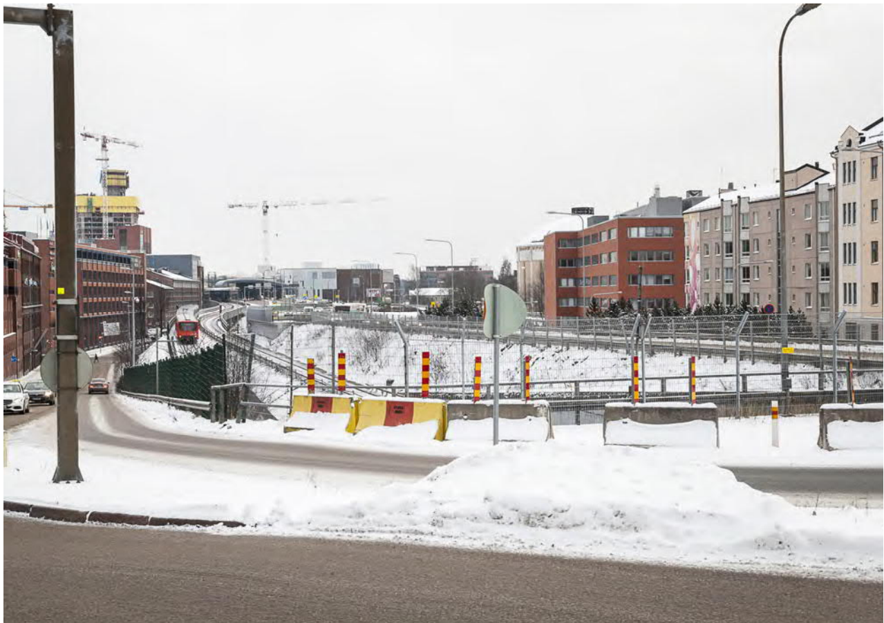
Näkymä Kruununmakasiinin päädystä itään. Itäväylältä Kalasatamaan tullessa täytyy ajaa tänne asti ja palata takaisinpäin Lautatarhankatua (vas.). Keskellä metrorata joka sukeltaa tässä kohdassa tunneliin.
