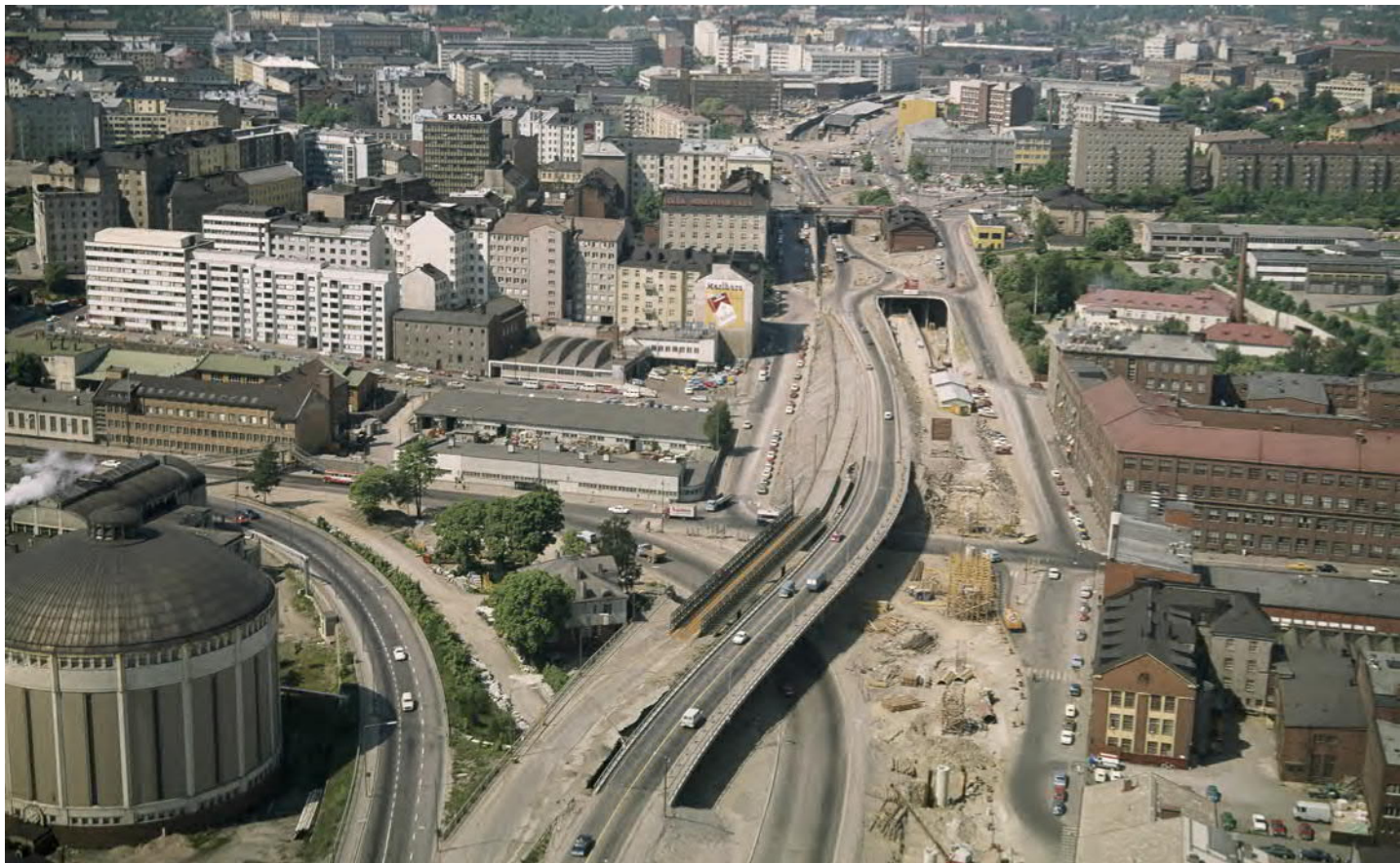
Junatien silta ja metrotyömaa vuonna 1973. Helsingin kaupunginmuseo.
