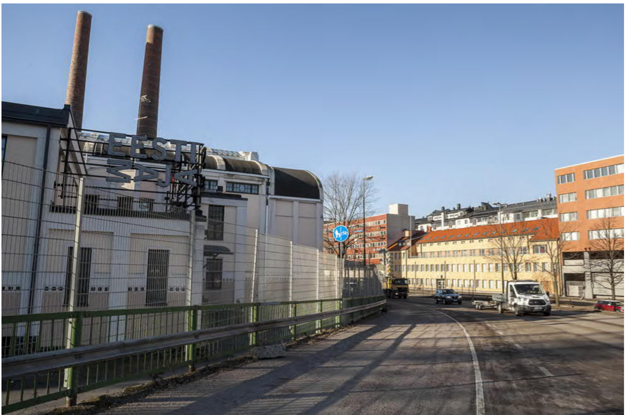
Näkymä Sörnäisten rantatien suuntaan, vasemmalla Suvilahden kattilahalli.
