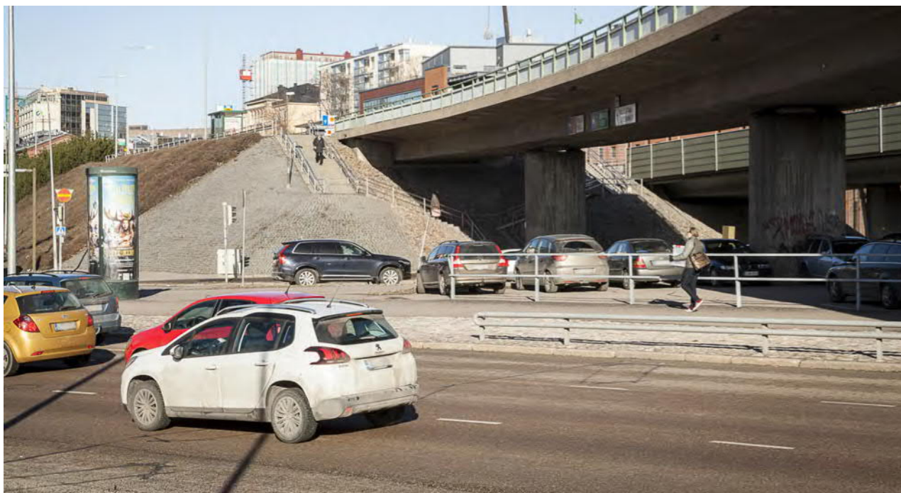
Junatien bussipysäkeille on kulku pelkästään portaiden kautta. Etualalla Junatien liittymä Sörnäisten rantatielle.
