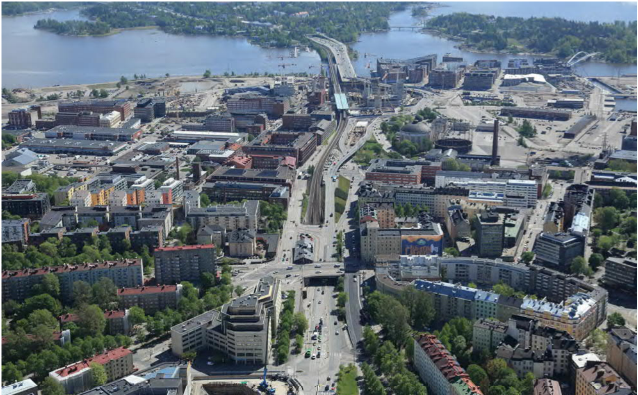
Junatien alue luoteen suunnasta nähtynä. Edessä Hämeentien silta, takana Kalastama ja REDIn työmaa. Kuva Helsingin kaupunki
