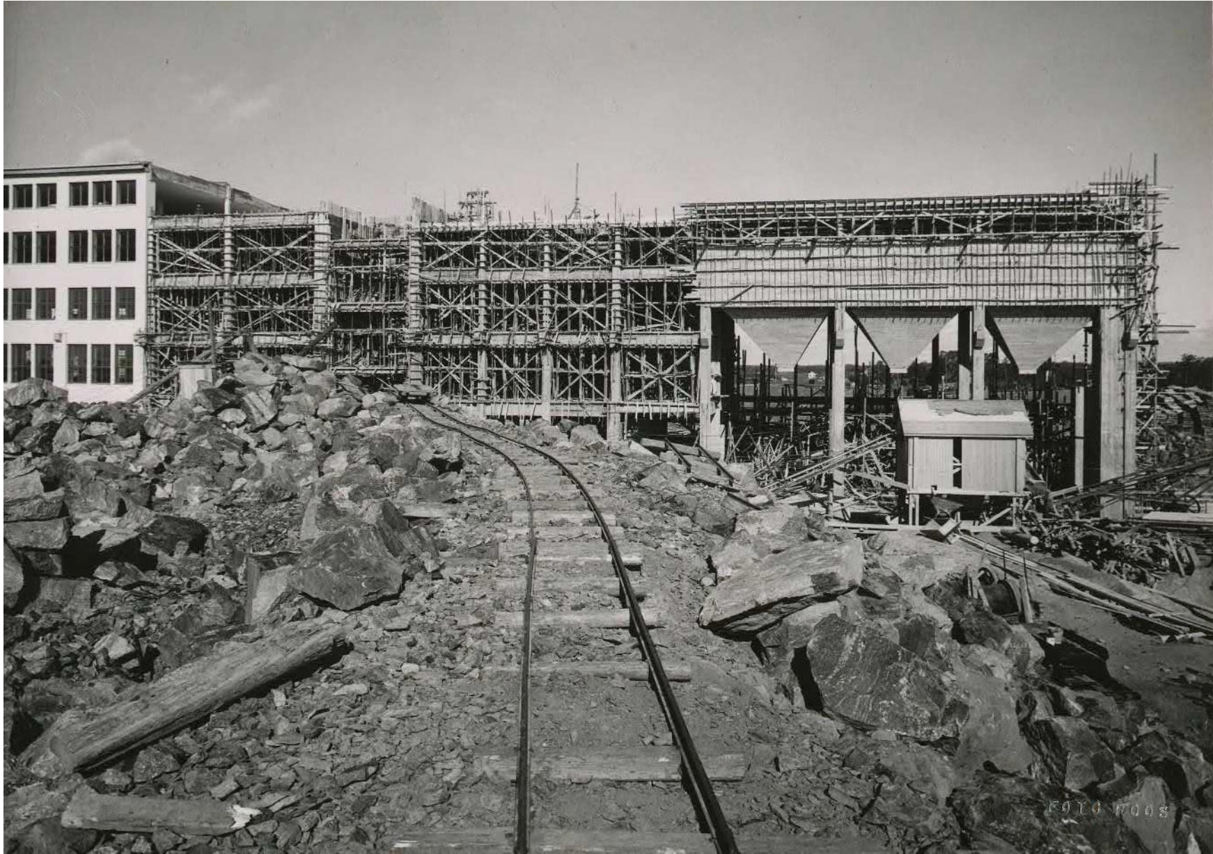
10.9.1942 päivätty kuva Kaapelitehtaan rakennustyömaalta. Keskellä työmaan ratarakennelma, oikealla tuleva pannuhalli. /Nokia
