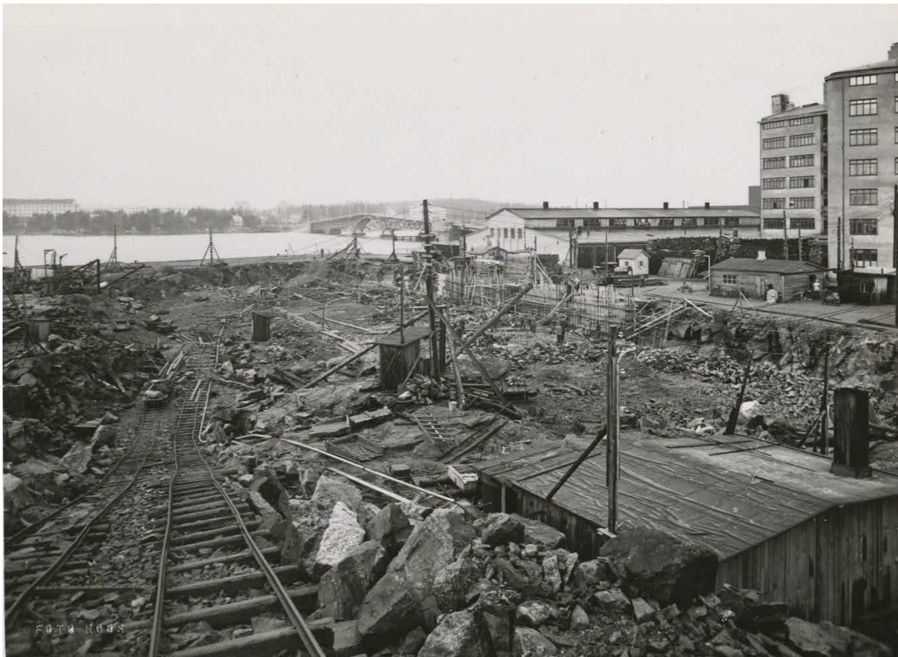
Näkymä kohti Lauttasaarta ja Lauttasaaren siltaa Kaapelitehtaan rakennustöiden aloittamisen akoihin 23.11.40 /Nokia
