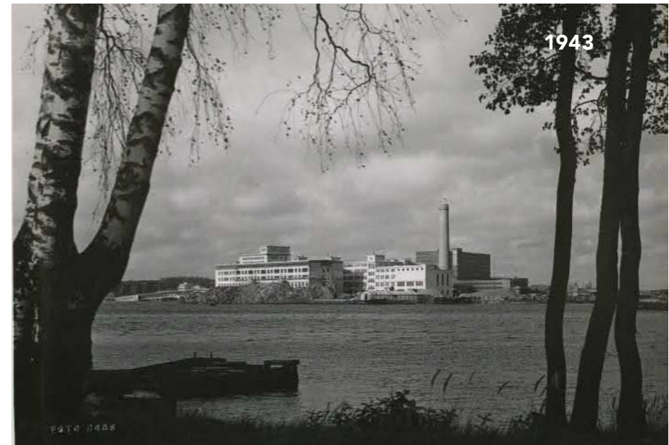
Merikaaplihallin ensimmäinen vaihe ja pannuhalli ovat valmiina, piipun rakentaminen on vielä kesken. /Nokia
