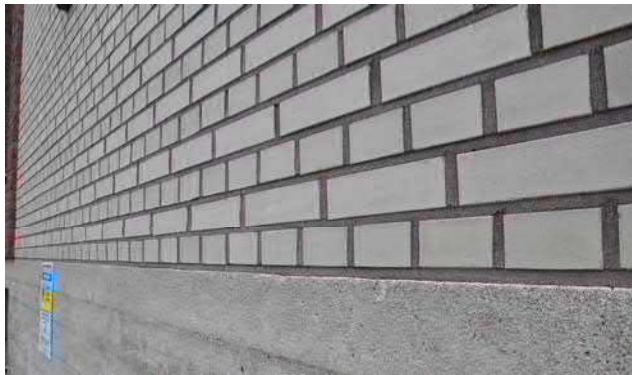
Tammasaarenlaiturin puoleisen julkisivun kahi-tiilet korvattiin poltetuilla tiilillä. Kuva 2017.
