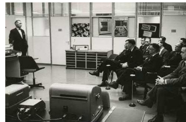
Ajoittamattoman kuvan taustalla tehtaanaikaisia väliseiniä. / Nokia
