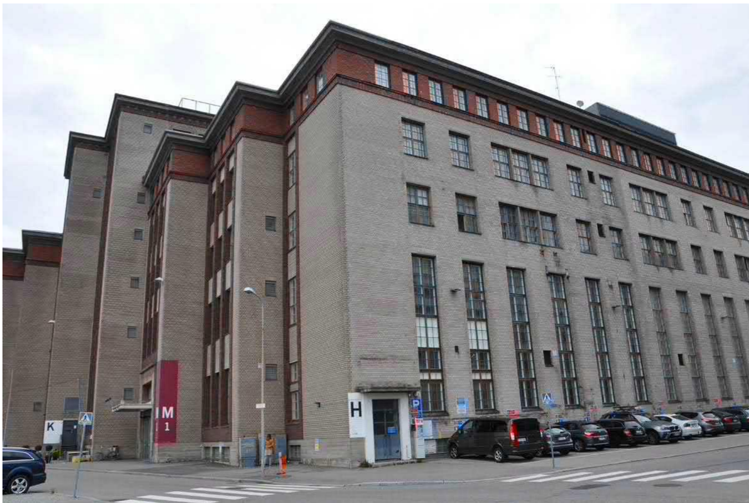
Päädyn uuden tiiliverhouksen (poltetusta tiilestä) ja sivujulkisivun vanhan kalkkihiekkatiilimuurauksen erot hälvenevät kauempaa tarkasteltaessa. Korkeiden ikkunoiden rivissä kuusi ensimmäistä vasemmalta alkaen on uusittu korjausperiaatteista poiketen.
