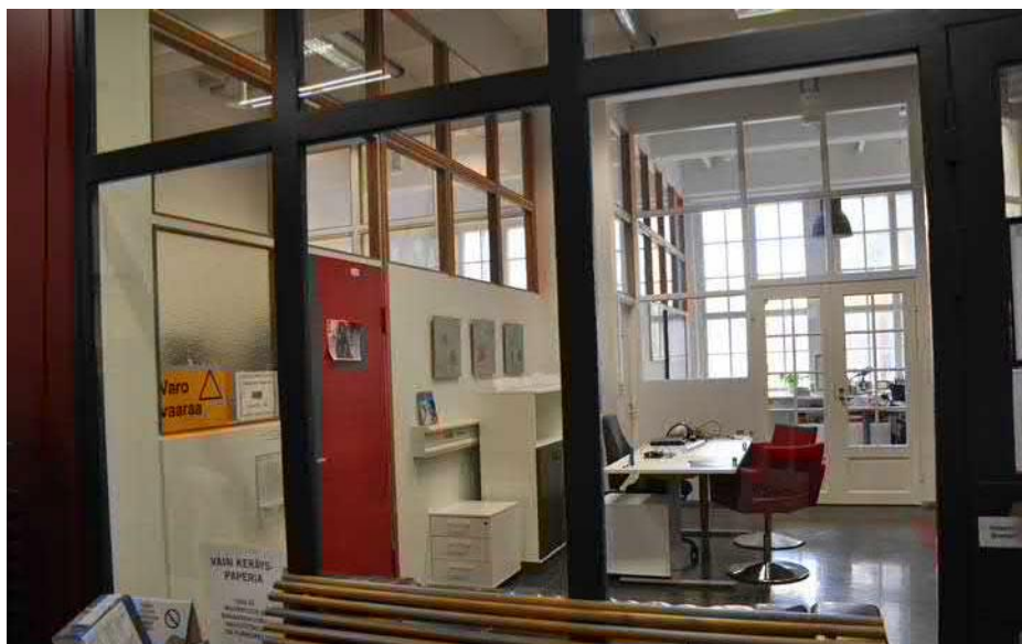
Koy Kaapelitalon toimsito avautuu 2.keroksen aulaan. Toimistilaa on jaettu tehtaankaisilla väliseinillä, jotka on siirretty muualta talosta sekä uusilla lasiväliseinillä.
