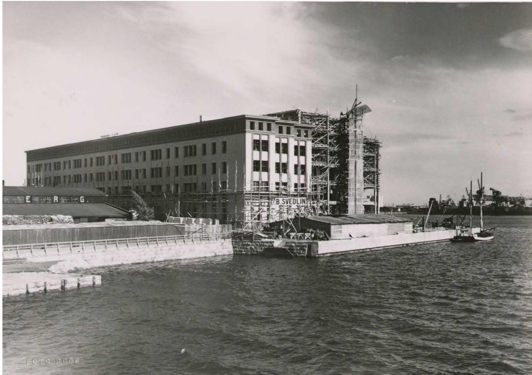
Kaapelitehtaan päätyulkisivua rakennetaan 2.7.1942. Rannassa näkyy aluksia, jotka kuljettivat työmaalle tarvikkeita ja materiaaleja. /Nokia
