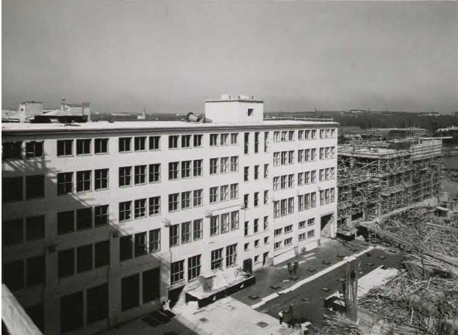
21.8.1942 Pannuhallin rakentaminen on aloitettu. /Nokia
