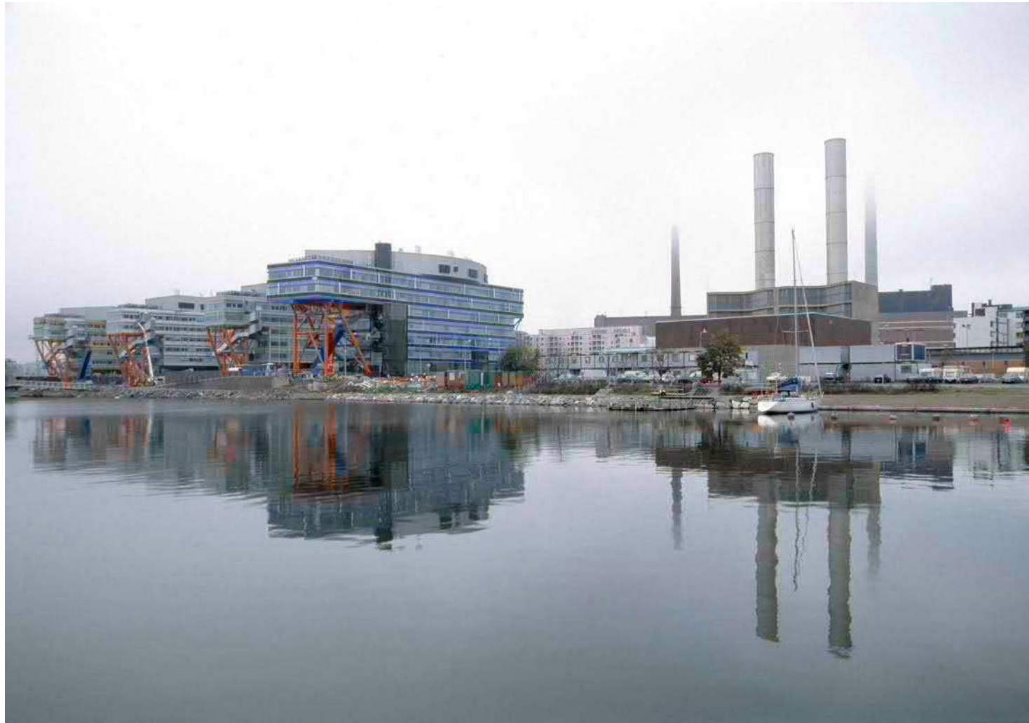
Ruoholahden kanava, Kellosaarenrannan toimistorakennuksia. Tekijä: Kiuru Sakari HKM,
