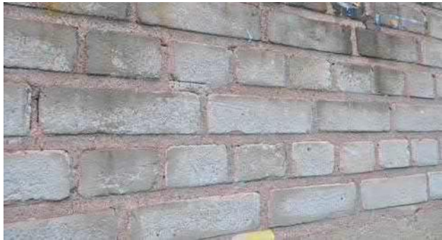
Alkuperäistä kalkkiehkeatiilipintaa ja saumausta Tammasaarenkadun puoleisella julkisivulla
