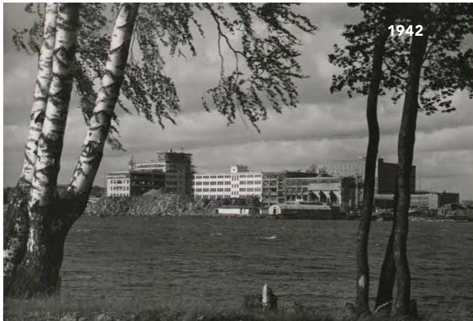
Kaapelitehdas rakenteilla. /Nokia
