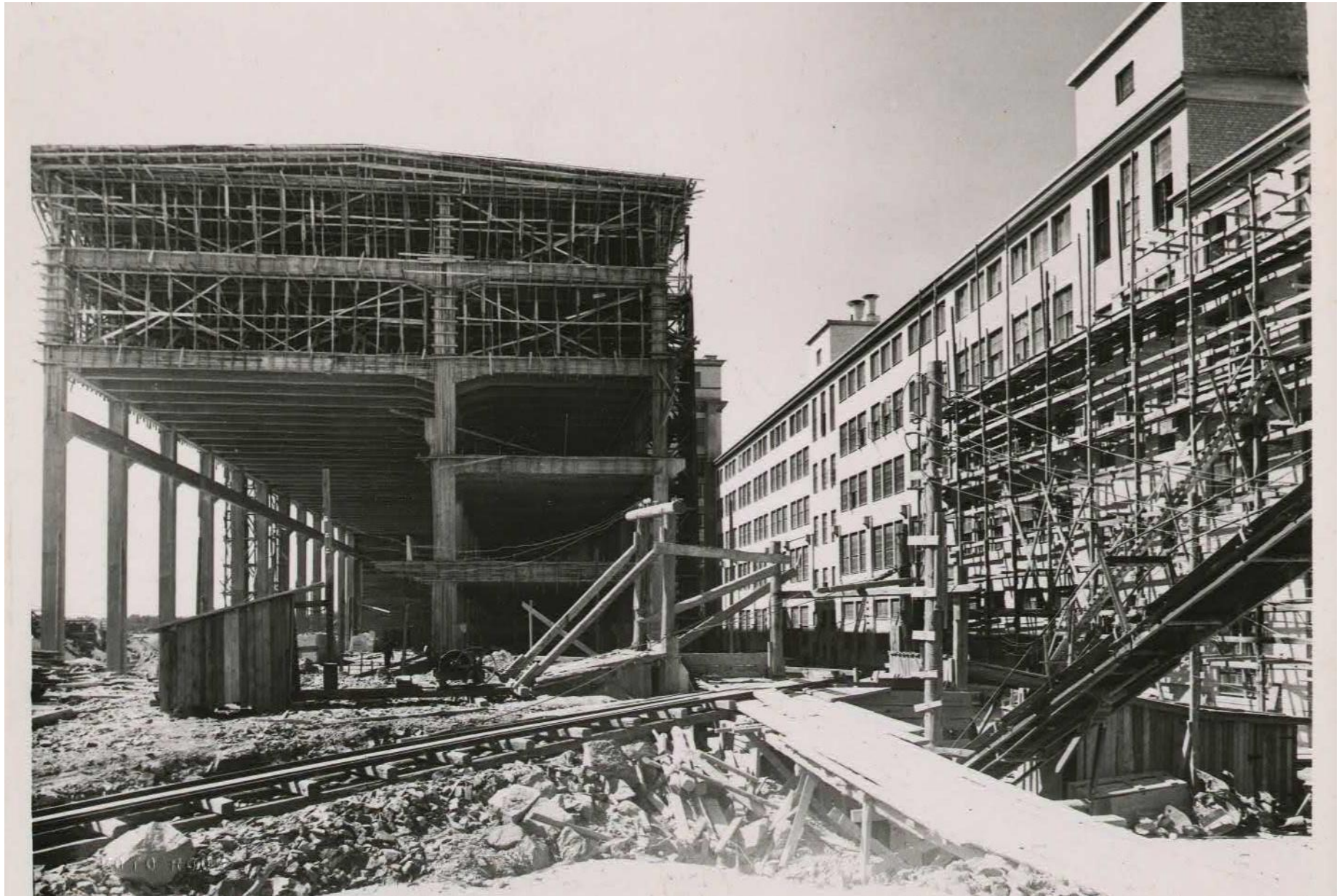
24.7.1943 päivättyssä kuvassa Kaapelitehtaan rakennustyömaalta näkyy Merikaapelihallin rakenne. /Nokia
