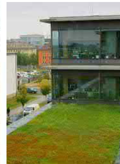
Esimerkkejä ekstensiivisistä viherkatoista, joilla erityyppisiä maksaruohomattoja, sekä erilaisista kansipihojen ratkaisuista.
